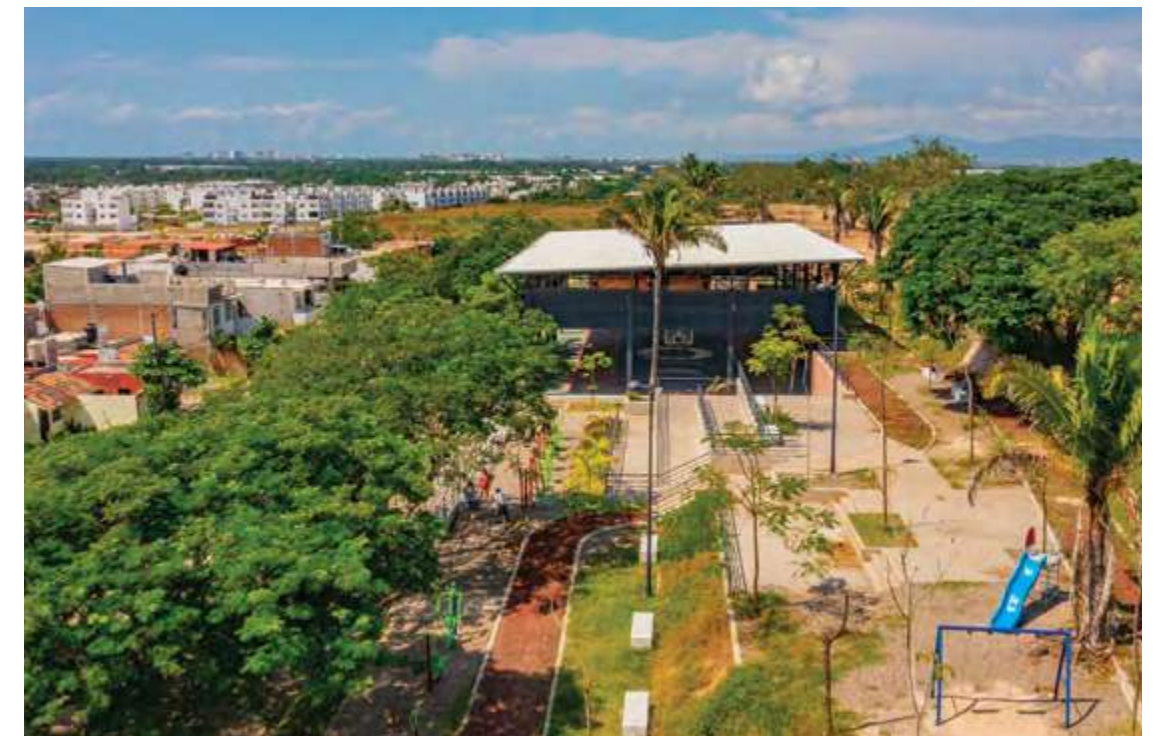
PUERTO VALLARTA - VISTA AÉREA DE MÓDULO DEPORTIVO LA MONTAÑA
