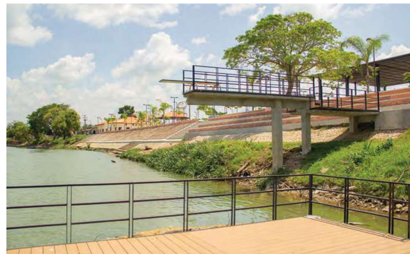
VISTA DEL ESPACIO PÚBLICO
