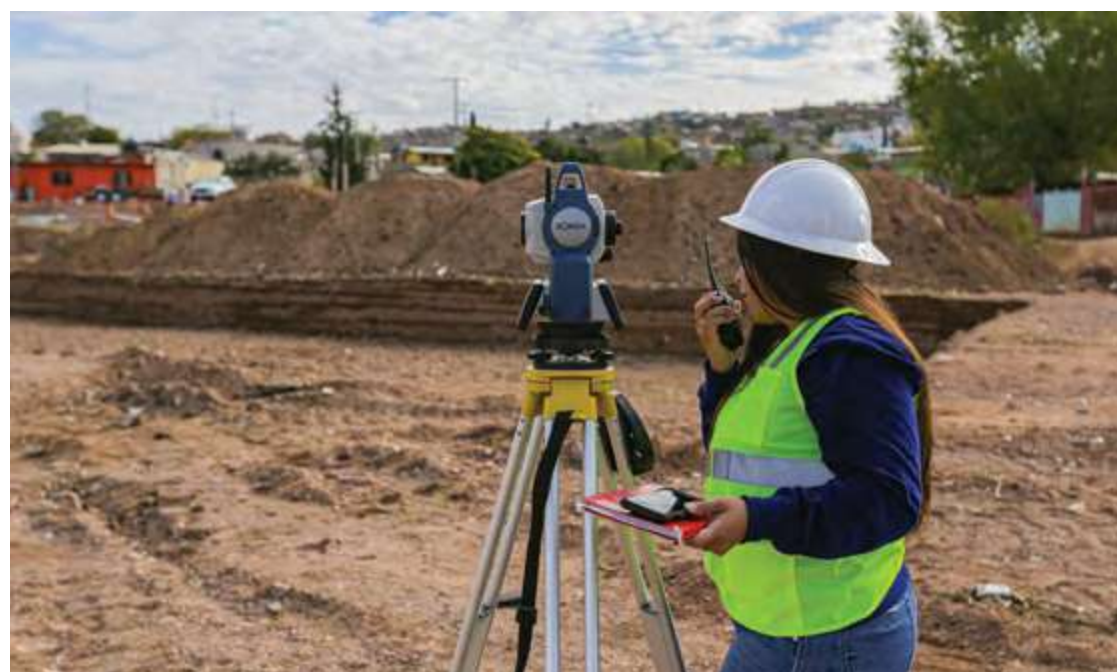
PROCESO CONSTRUCTIVO REPRESO NOGALES
