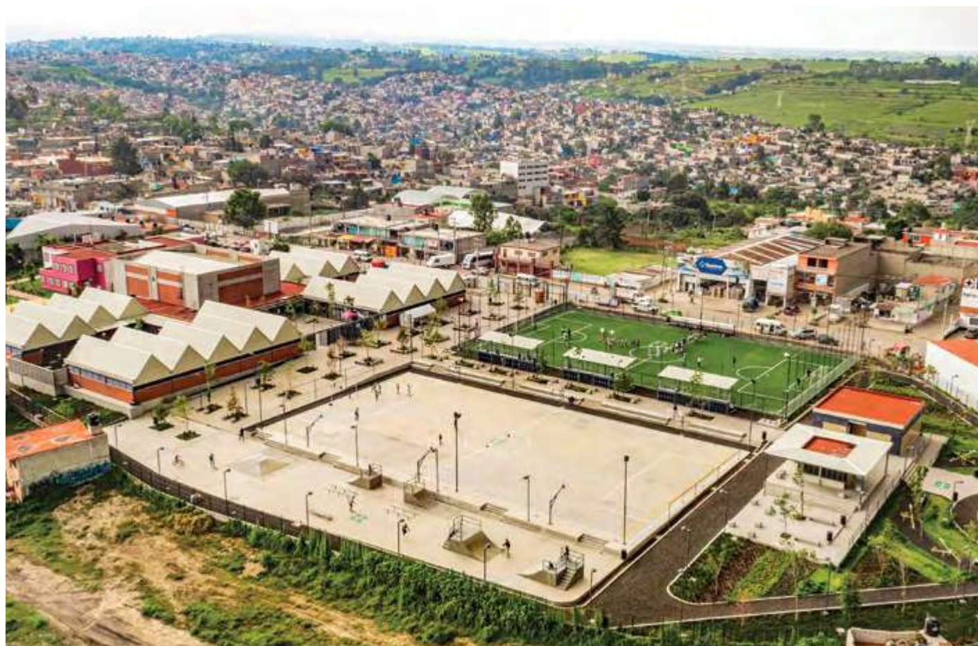
VISTA DE ÁREA DE CANCHA
