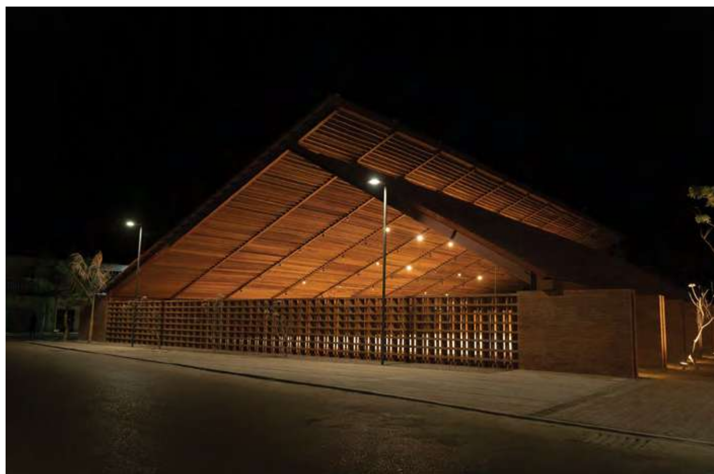
VISTA DE LA CASA DE LA CULTURA
