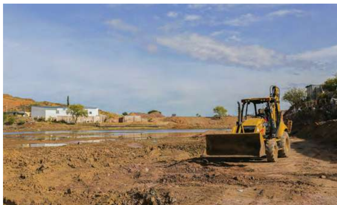
PROCESO CONSTRUCTIVO REPRESO NOGALES
