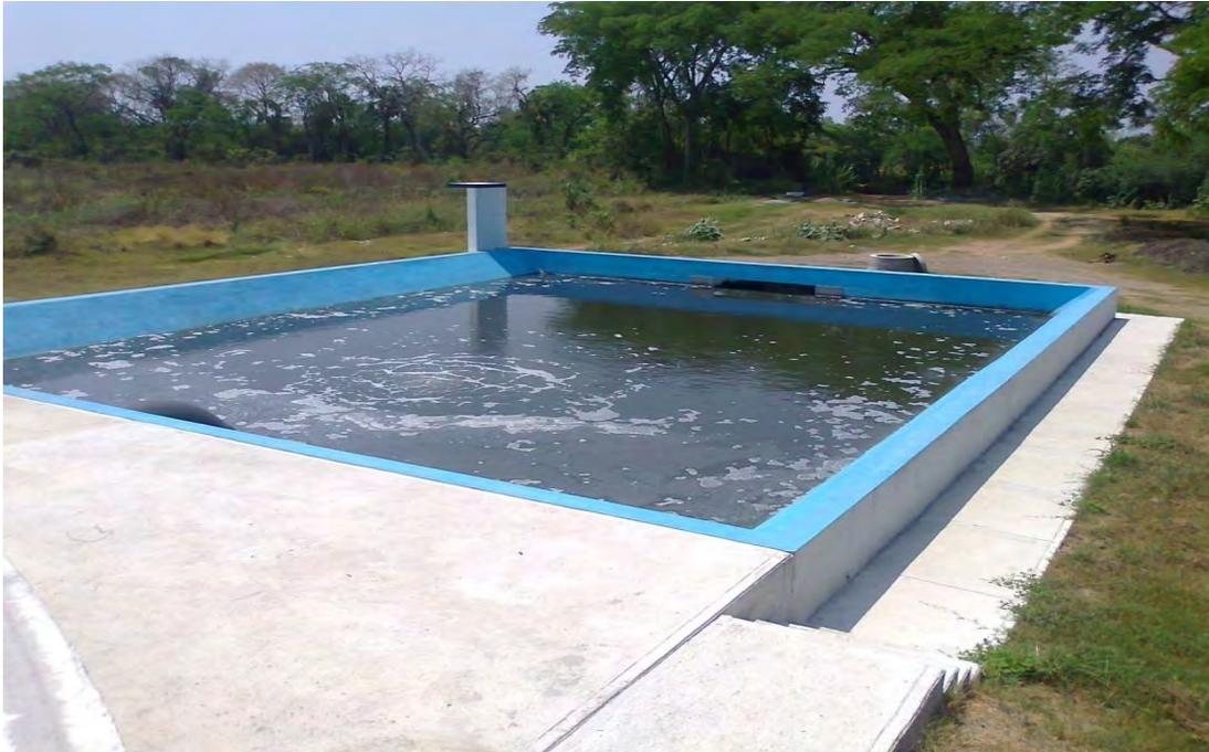
**Fig. 15** Tanque de contacto de cloro, dosificación y mezclado, el agua se retiene durante media hora para eliminación de microorganismos.
