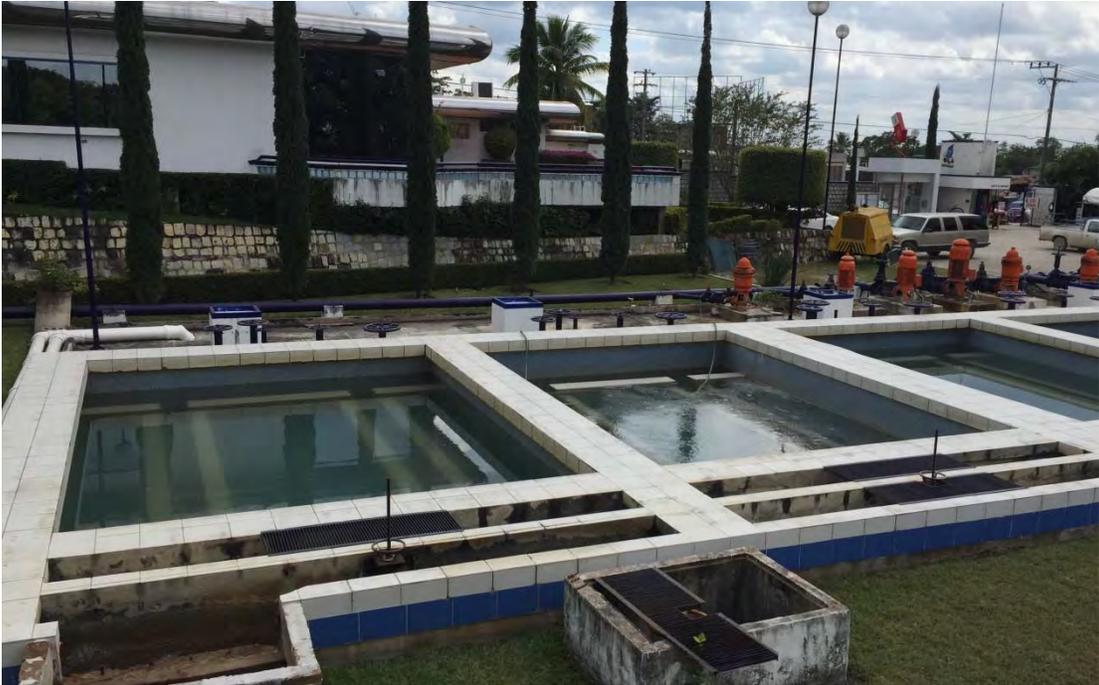
**Fig. 7** Módulo de filtración.
