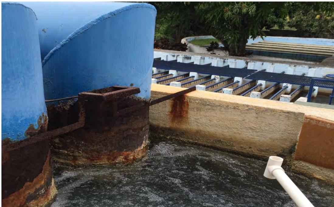
**Fig. 4** Descarga del agua cruda proveniente de las líneas de conducción de la bocatoma del Rio Valles, donde se dosifica una solución de cloro antes del proceso de potabilización.
