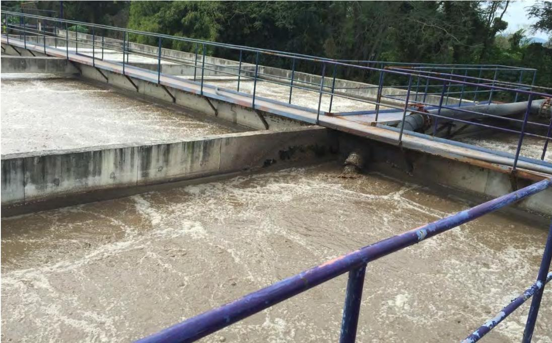
**Fig. 13** Reactores de la planta de tratamiento “Birmania”, que cuenta con un sistema de difusión de aire, con sopladores de 125 hp.
