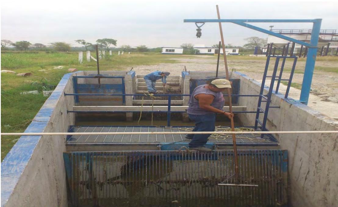
**Fig. 10** Desarenador localizado en la recepción de las aguas residuales que ingresan a la planta de tratamiento “Birmania”. Cuenta con tres tipos de criba 1”, 1/2” y 1/4”.
