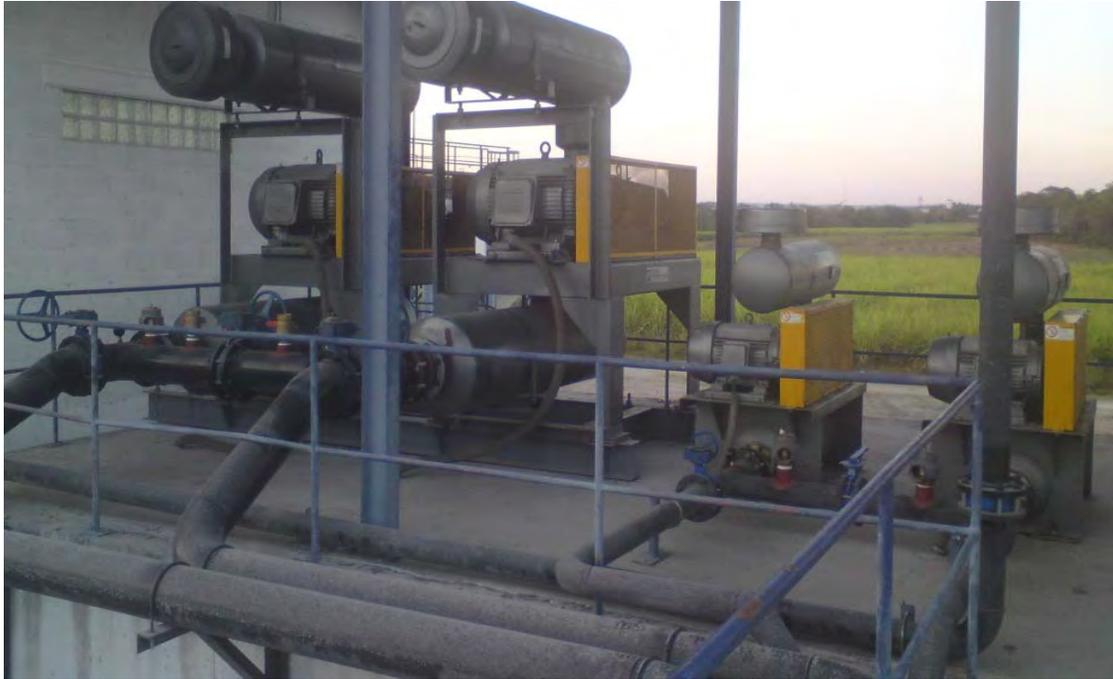
**Fig. 11** Sistema de aireación, cuenta con vigas con sistema anti-vibratorio, válvulas de acero, de alivio y medidores a presión a todos los sopladores.
