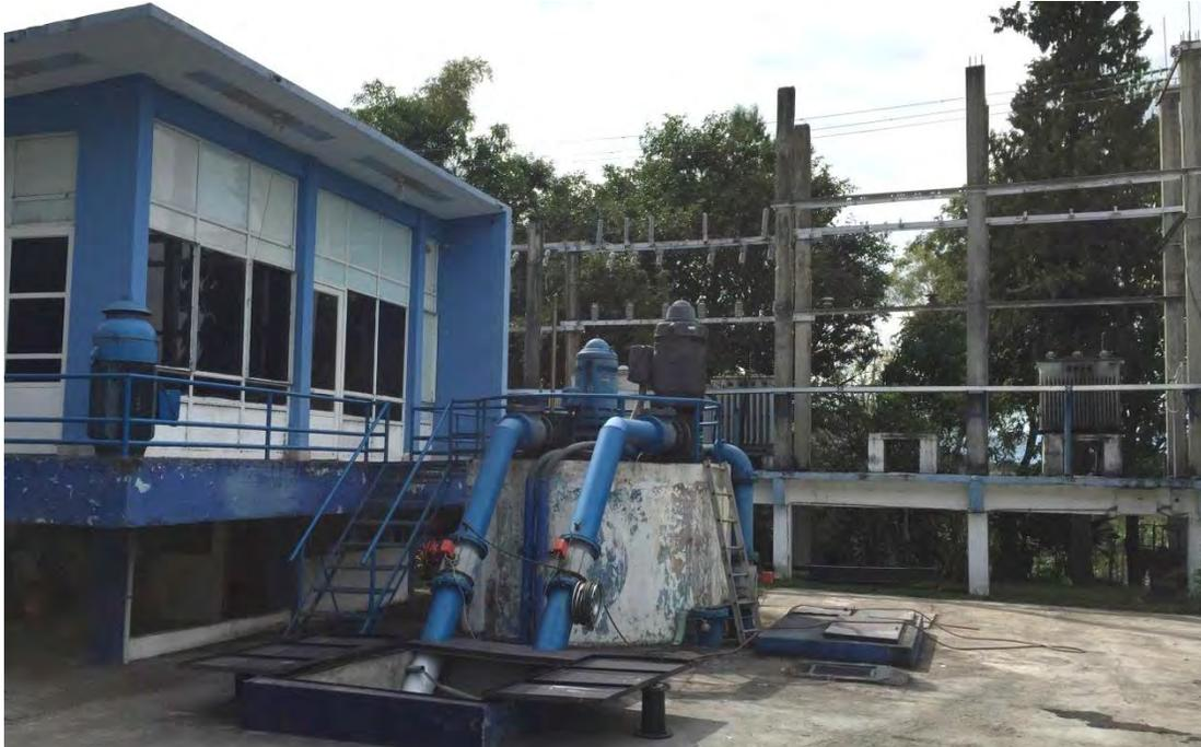
**Fig. 1** Cárcomo número 1, donde se encuentran instalados dos equipos de bombeo verticales, que alimenta a la línea de conducción No. 1 de 18" de diámetro.
