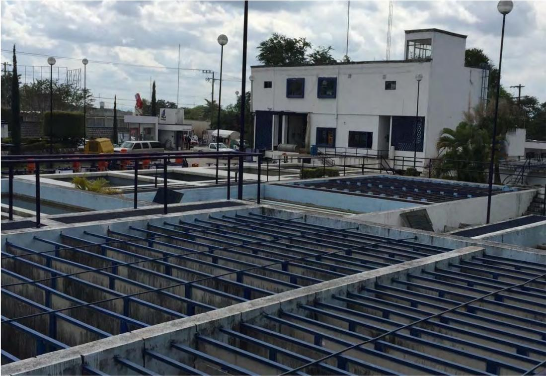
**Fig. 5** Módulo de floculación.
