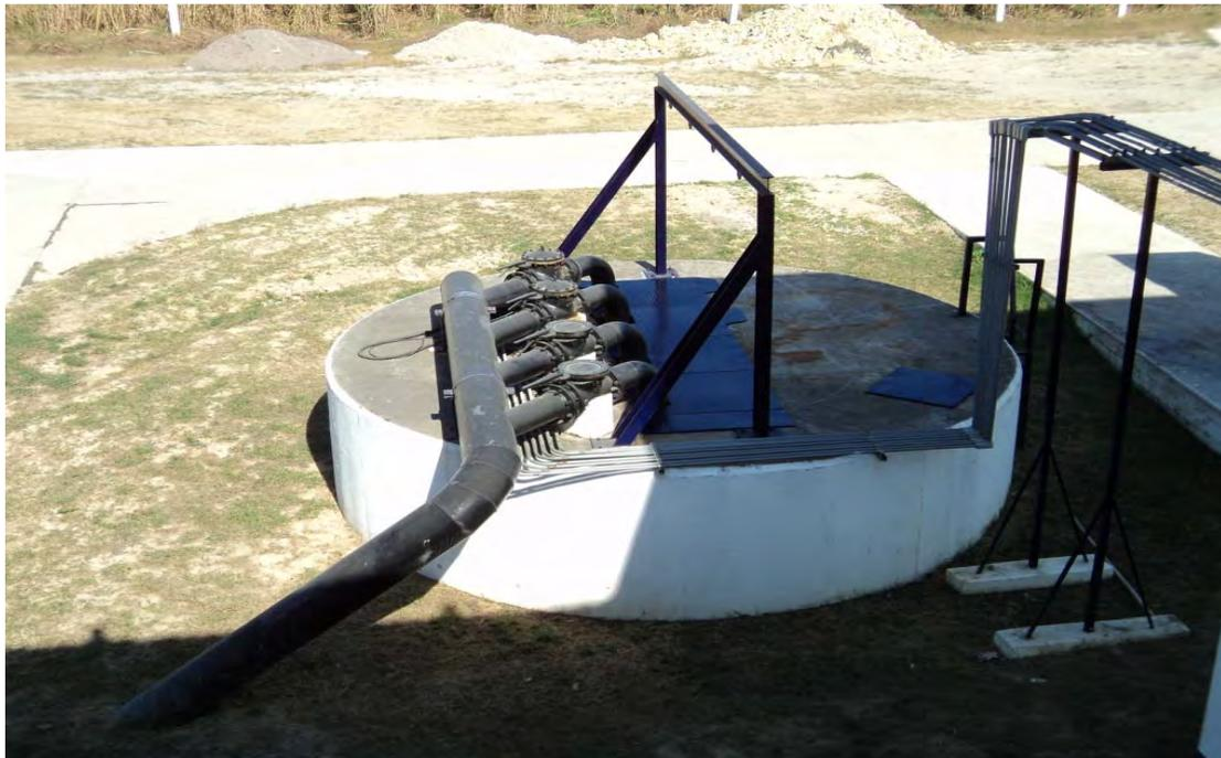
**Fig. 12** Cárcamo de bombeo de la planta de tratamiento “Birmania”, que consta de 4 bombas de 25 hp.
