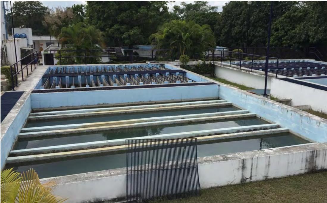
**Fig. 8** Módulos de floculación y sedimentación.
