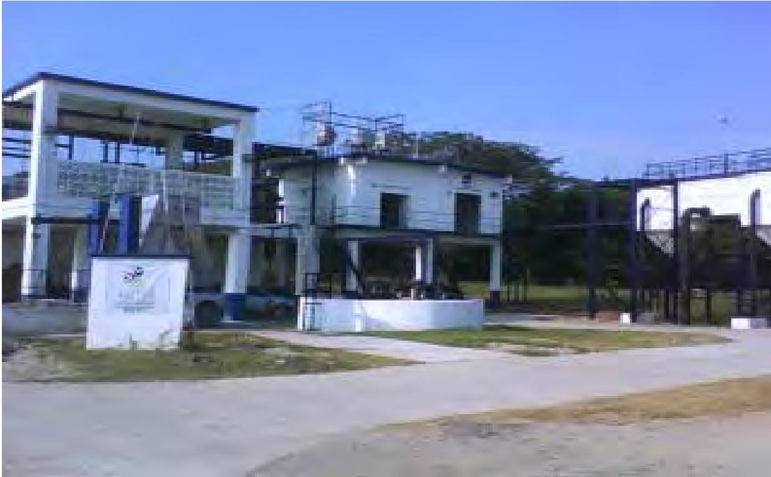
**Fig. 9** Planta de tratamiento de aguas residuales de lodos activados “Birmania” localizada a las afueras de la zona urbana de Ciudad Valles.
