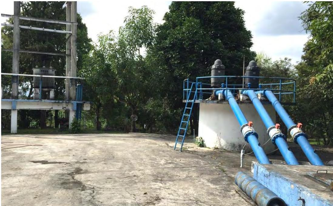
**Fig. 2** Cárcomo número 2, donde se encuentran instalados tres equipos de bombeo verticales, que alimentan a las líneas de conducción No. 2 y 3, de 20" y 18" respectivamente.
