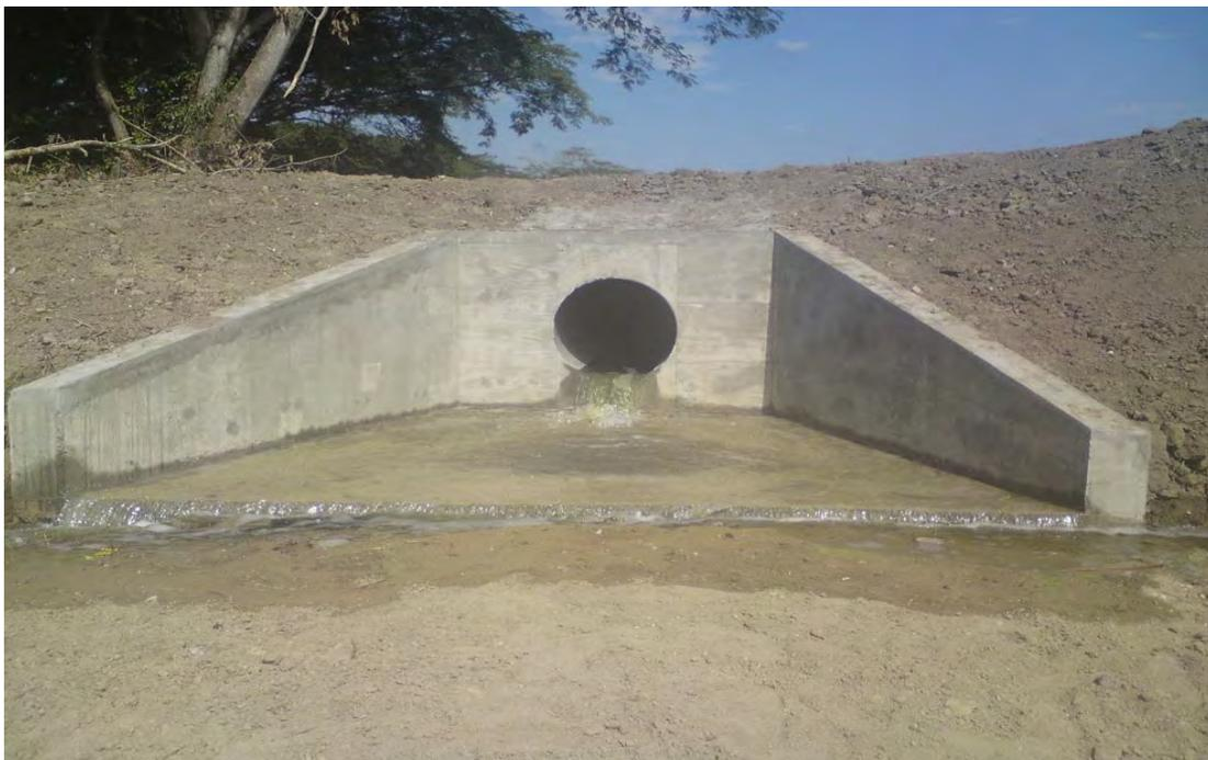
**Fig. 18** Descarga de agua tratada de la planta de tratamiento de aguas residuales “Birmania”, hacia el Rio Valles. Reforzada con piedra para evitar erosión y deslaves.
