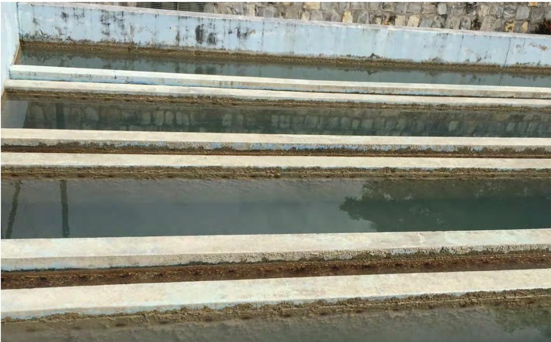
**Fig. 6** Módulo de sedimentación.
