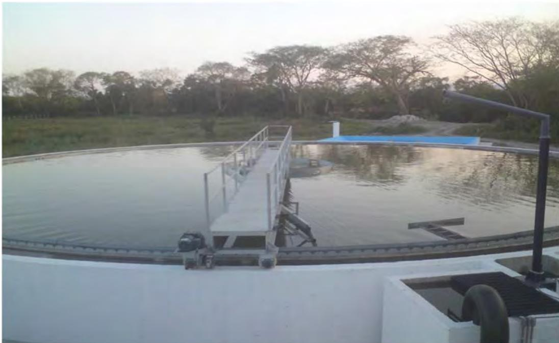
**Fig. 14** Claris sedimentador, donde se sedimentan los lodos para su retorno a los reactores y decanta el agua tratada de la parte superior del tanque.
