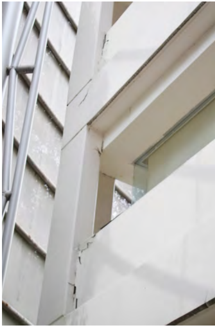
Fachada Posterior del Edificio Sede
