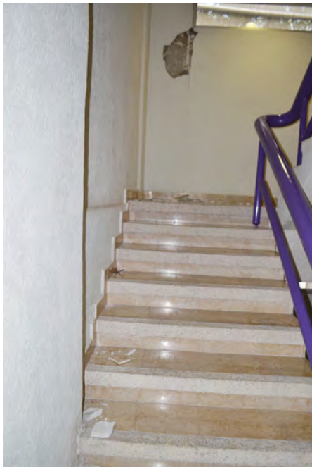
Escaleras del 1° al 2° Piso
