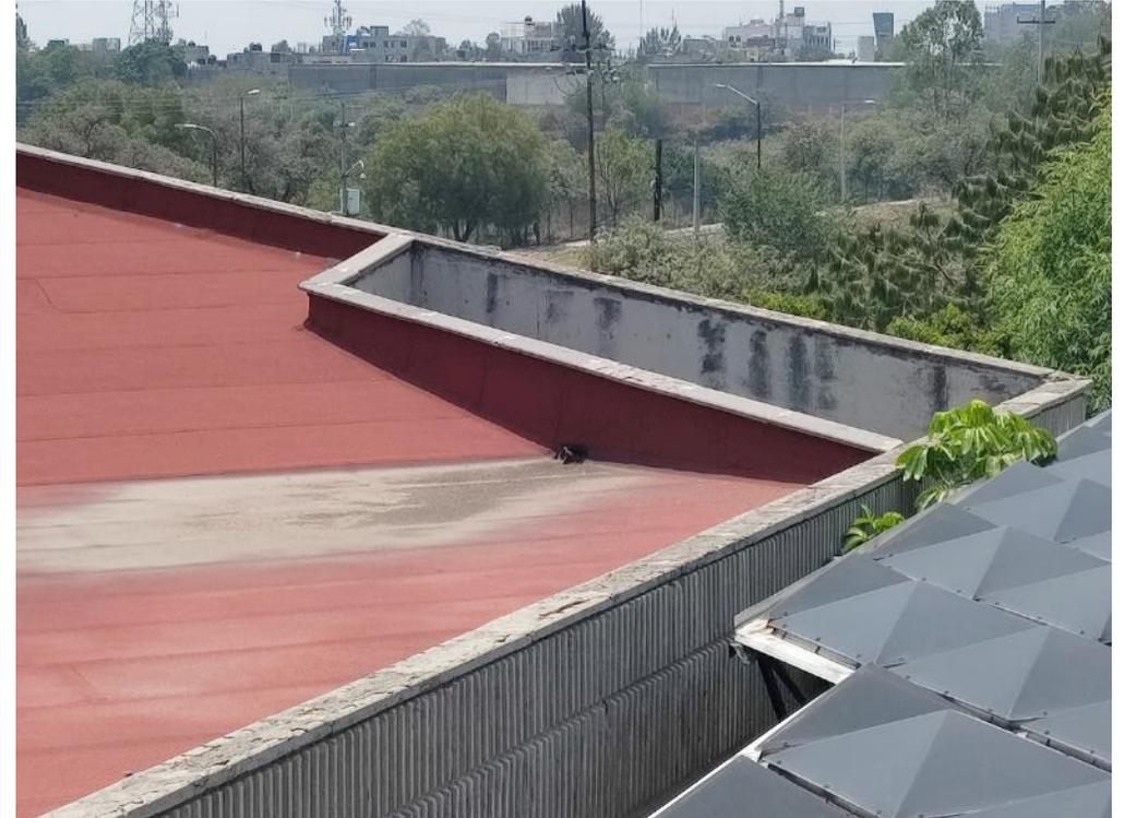
Azotea del auditorio. Se observan marcas de agua, por lo que se infiere que la carpeta impermeabilizante, y probablemente la bajada de agua pluvial, presentan problemas de encharcamiento y acumulación de basura. Asimismo, se recomendaría revisar las pendientes del sistema de impermeabilización y el estado de las tuberías.
