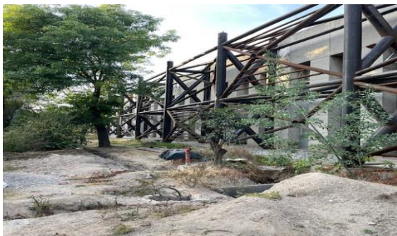
Vista fachada sur
