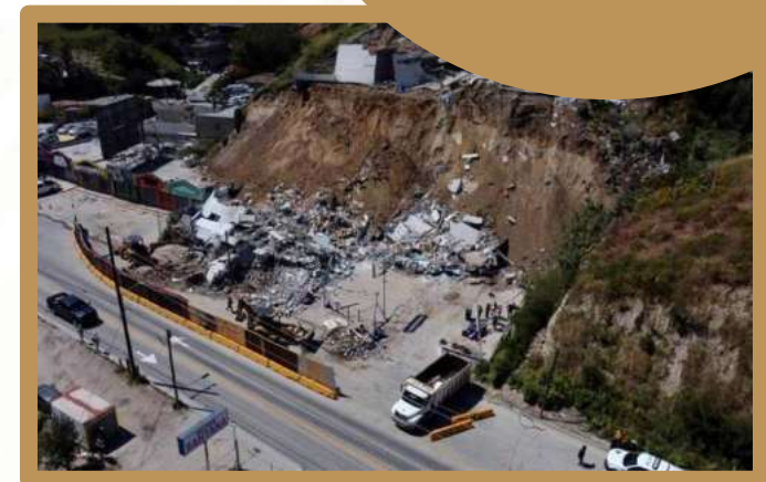
Escenario 3 Deslizamiento de ladera por lluvias intensas que afectan las viviendas de la colonia A
