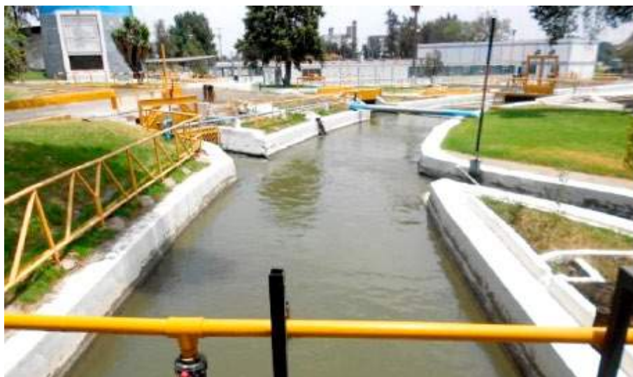
Canal de entrada
