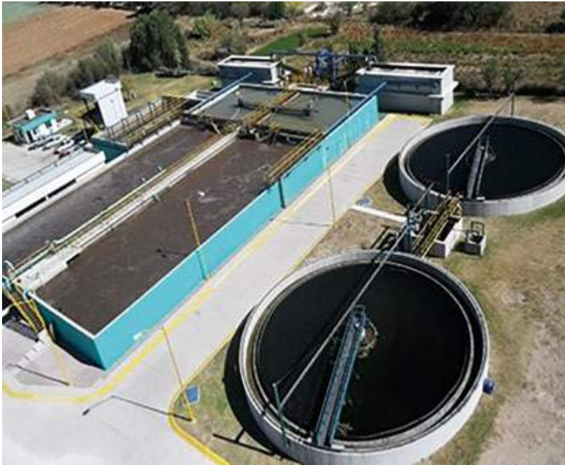
Reactores aerobios y sedimentadores secundarios
