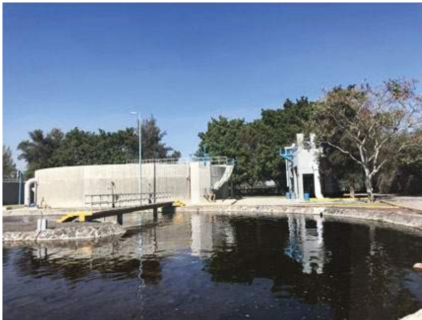
Sedimentador secundario
