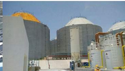
Digestor anaerobio de lodos
