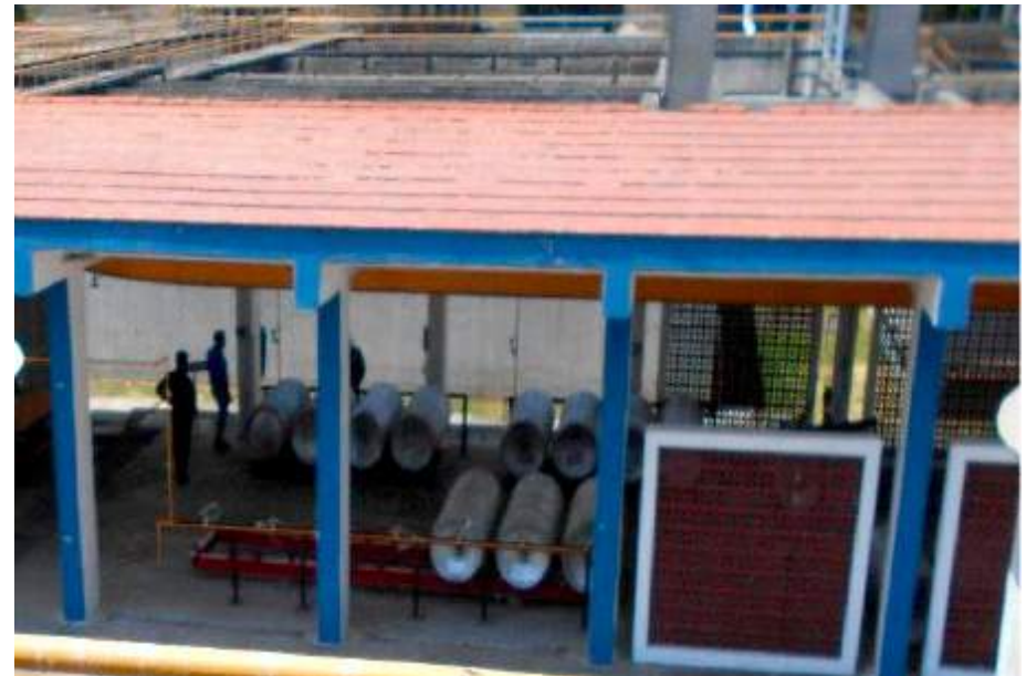
Edificio de cloración
