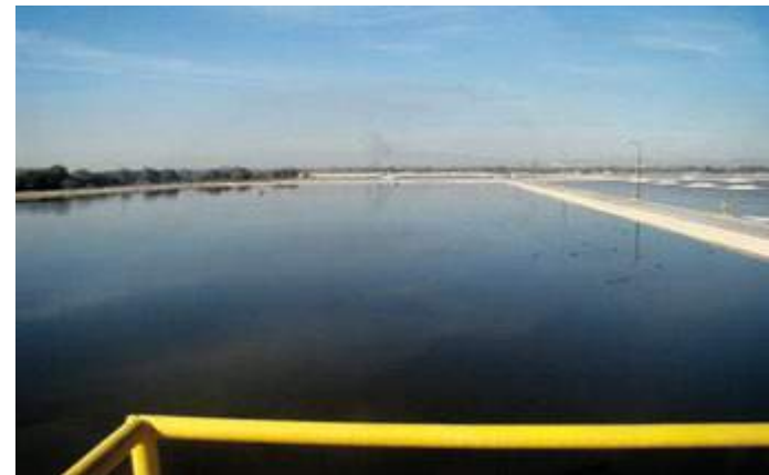
Laguna de Maduración
