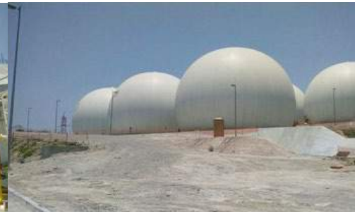
Almacenamiento de biogás
