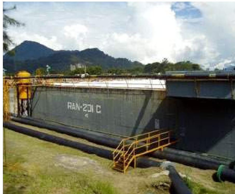
Reactor Anaerobio de Flujo Ascendente
