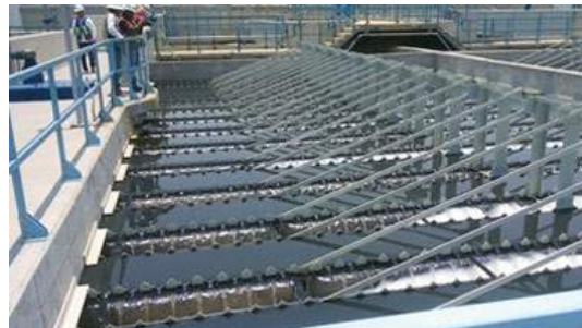
Sedimentador secundario
