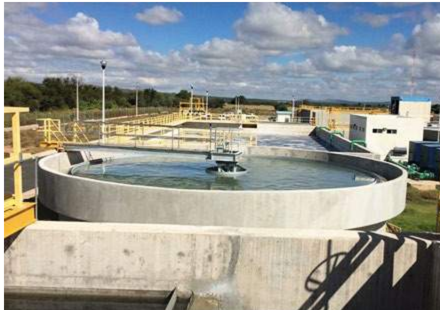
Sedimentador secundario
