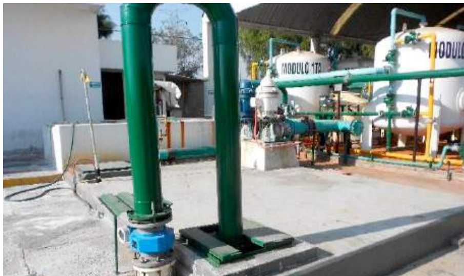
Cárcamo de llegada
