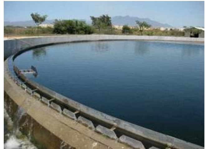
Sedimentador secundario
