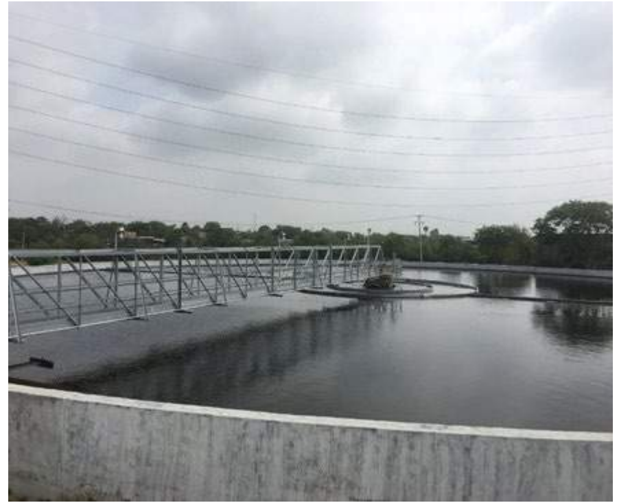
Sedimentador secundario
