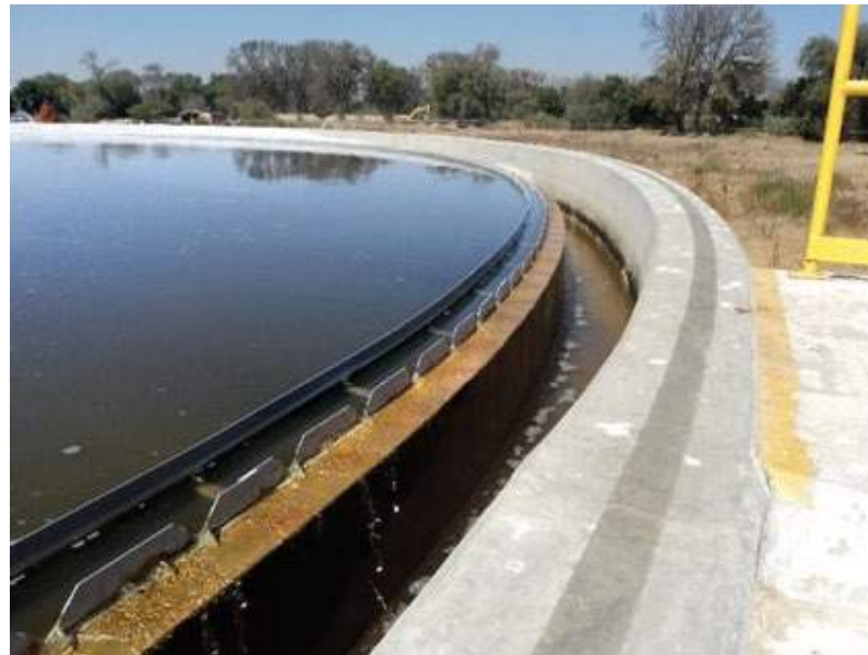
Sedimentador secundario
