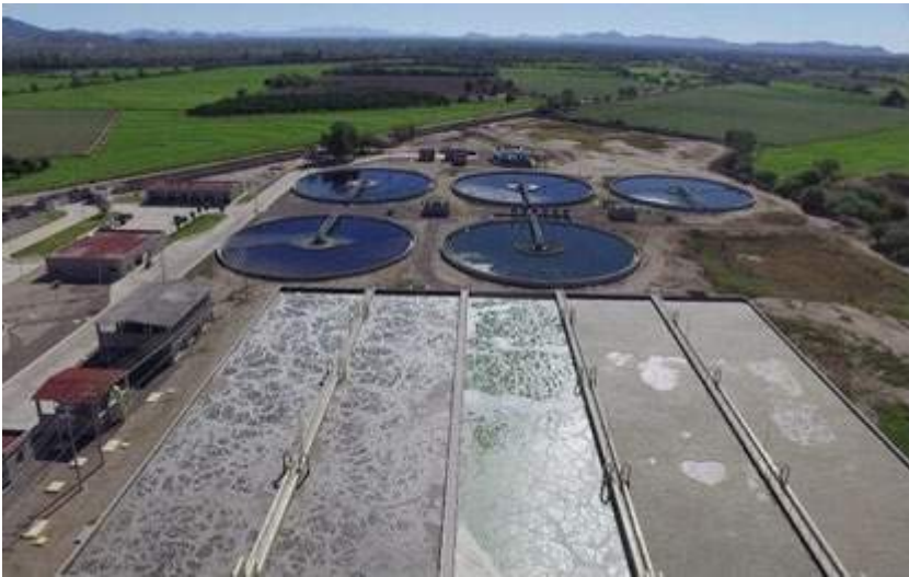
Vista aérea del sistema de lodos activados
