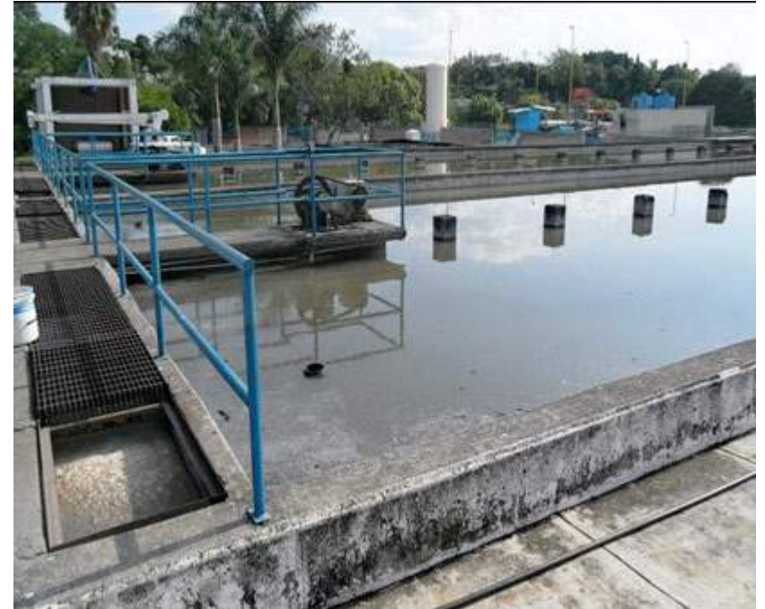
Sedimentador secundario
