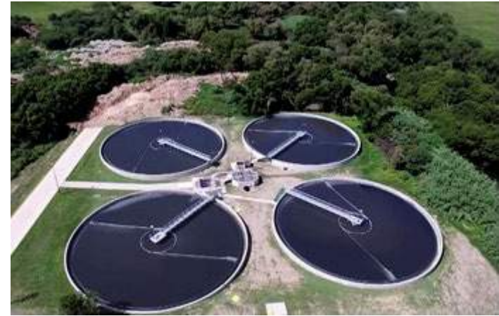
Sedimentador secundario
