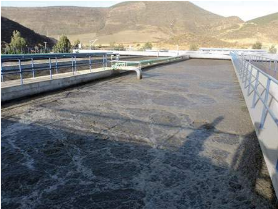
Zanjas de oxidación
