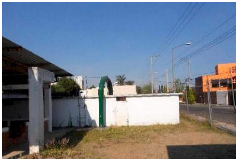
Tanque de almacenamiento
