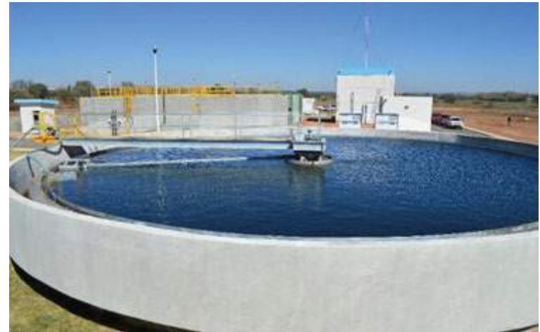
Sedimentador secundario
