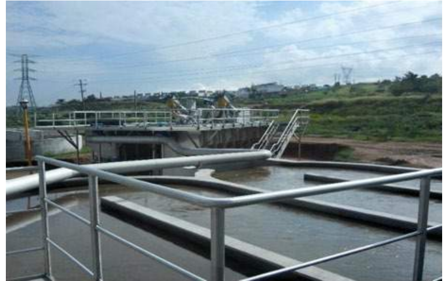
Zanja de oxidación
