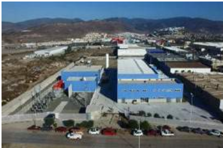
Vista general de la planta
