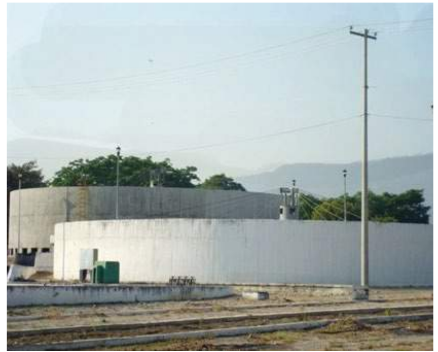
Filtros biológicos (percoladores)
