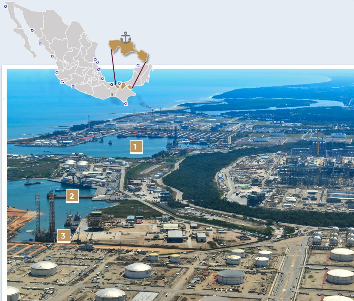
1. Terminal de Abastecimiento
