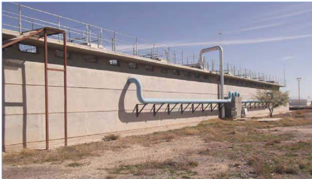
Figura 15. Planta de tratamiento de aguas residuales
