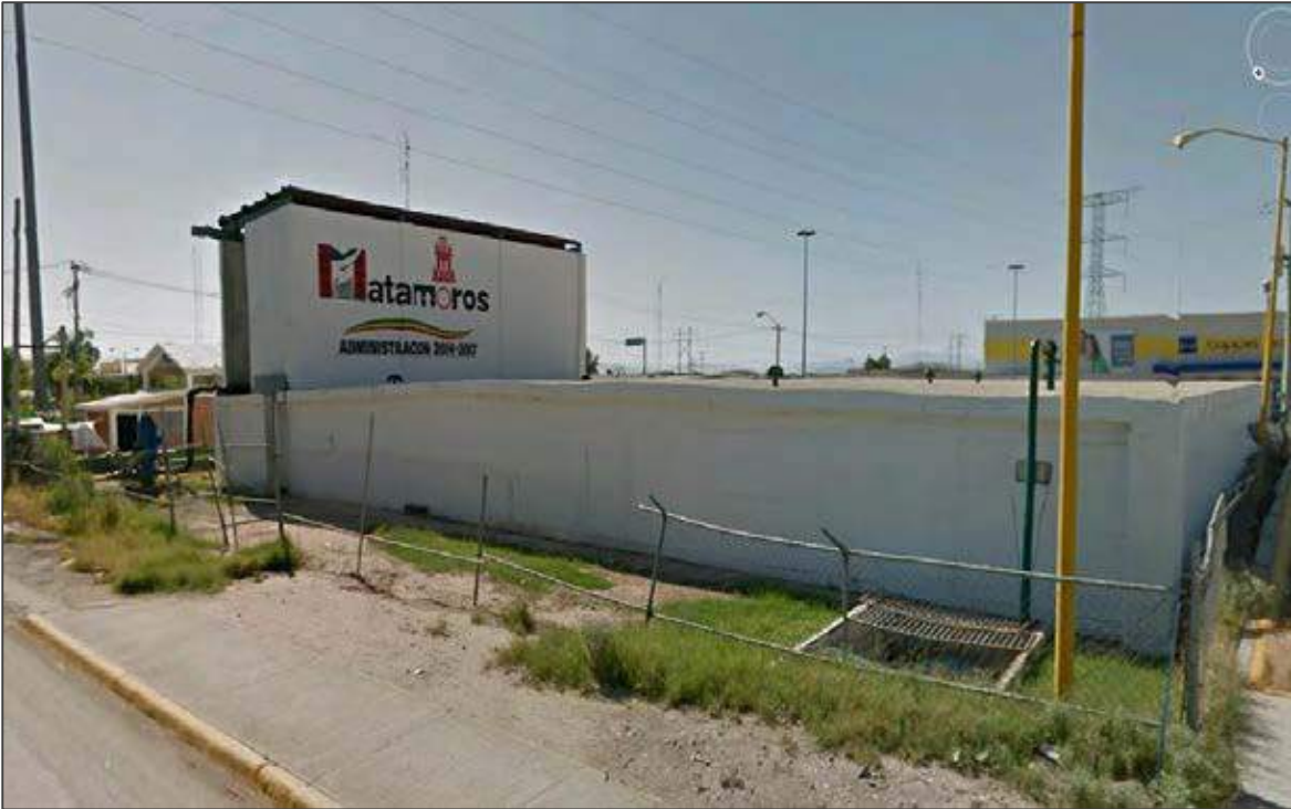
Figura 8. Tanque de almacenamiento
