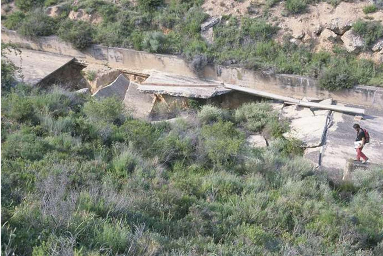
El canal de riego de Santa Ana, de **concreto no reforzado**, colapsado por un socavón en el valle de Noguera Ribagorzana, **Pirineo español**. Imagen tomada en mayo de 2003 .
