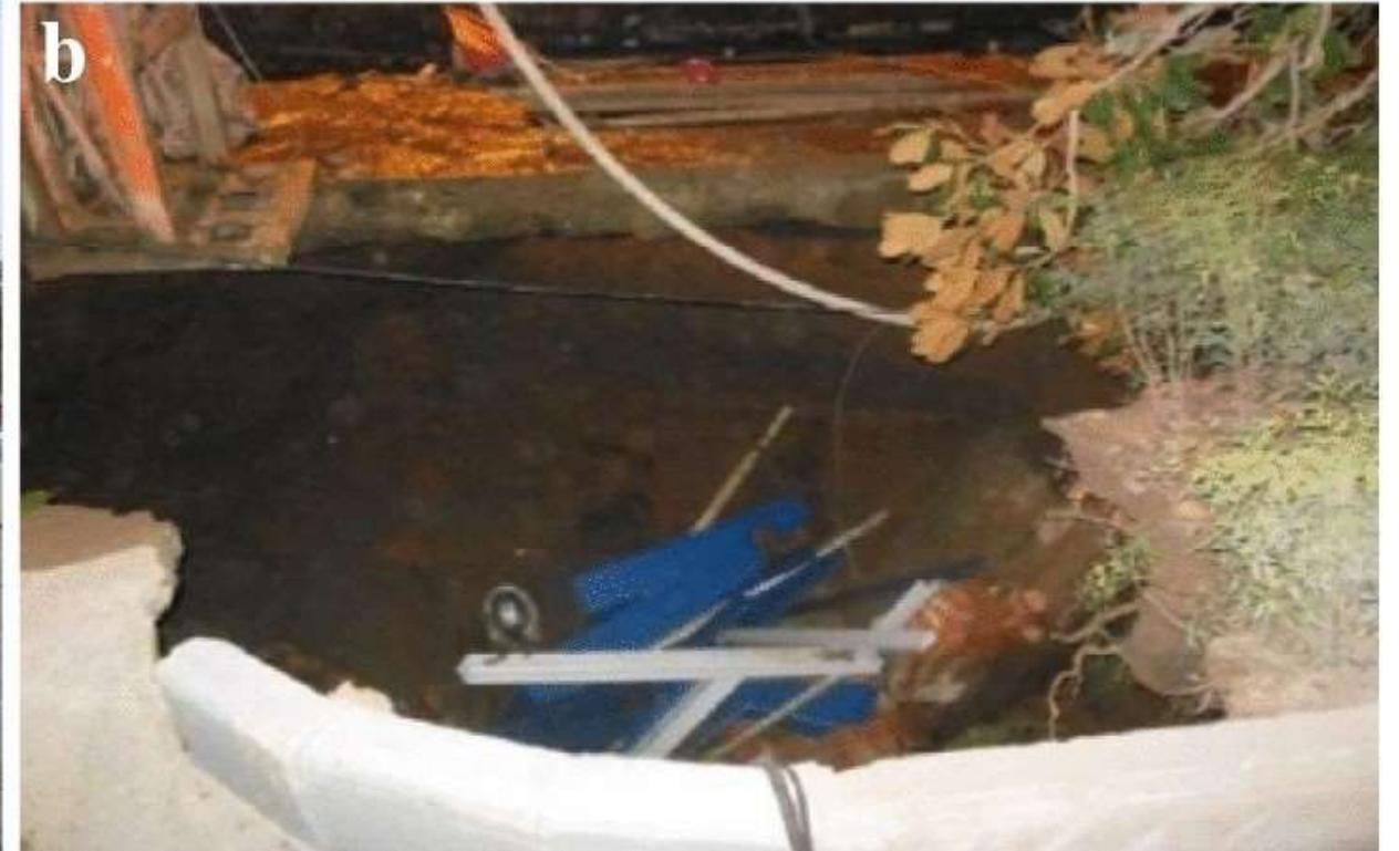
Fotografías del colapso del suelo inducido por un túnel de protección en:
