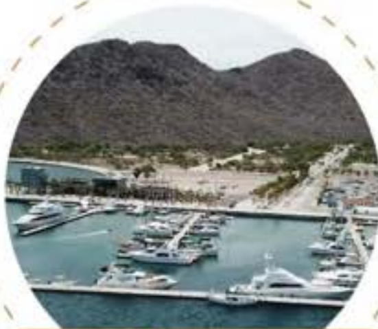
Marina Puerto Escondido
