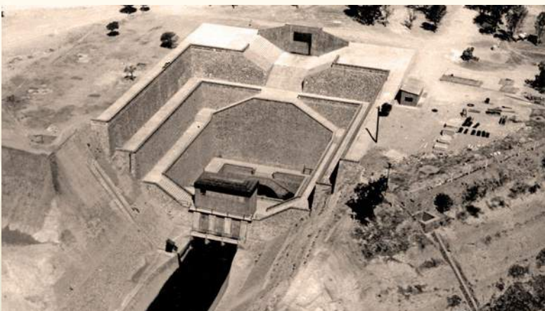
Vista del portal de entrada del Nuevo Túnel de Tequixquiac, concluido en 1954, que opera con el antiguo túnel para desalojar las aguas residuales y pluviales del Valle de México, 1965, Zumpango, Estado de México. CONAGUA-AHA, Fondo Colección Fotográfica, Caja 1450, Expediente 44483.
