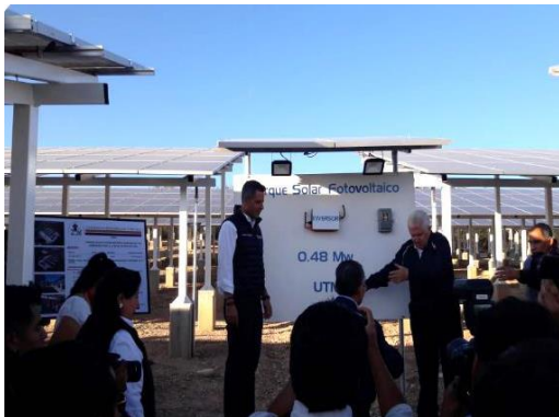
Fotografía 22. Sistema de paneles fotovoltaicos, junio de 2019, Huajuapán de León, Oax. Proyecto Jardín Solar fotovoltaico de 0.48 MW en la U.T.M.
