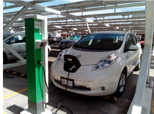
Fotografía 10. Vehículos eléctricos recargando, Aguascalientes, Ags., julio 2018. Proyecto Sustitución del Parque Vehicular a Gasolina por Vehículos Cero Emisiones 100%.
