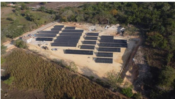
Fotografía 49. Vista aérea del Sistema Fotovoltaico para el bienestar de Colonia Juan N. Álvarez (Playa Ventura) localizada en el Municipio Copala del Estado de Guerrero México, noviembre de 2022, Tecnológico de Acapulco.
