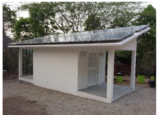
Fotografía 37. Sistemas fotovoltaicos para electrificación de El Madresal, Chis., febrero 2017, proyecto Centros Ecoturísticos. Instituto de Energías Renovables del Estado de Chiapas.
