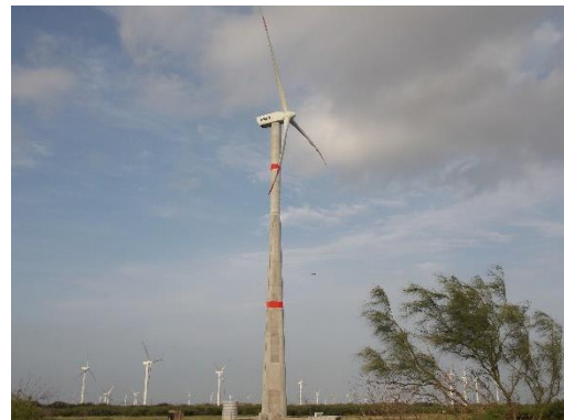
Fotografía 14. Aerogenerador de 2 MW clase 1, instalaciones del Centro Regional de Tecnología Eólica en Juchitán, Oax., marzo 2018, Proyecto Juchitán Sustentable. INEEL.
