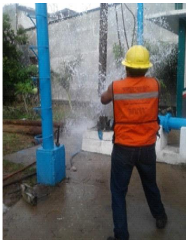
Fotografía 30. Mejora en bombeo Sistema de Agua Potable y Alcantarillado (SAPA), de Juchitán, Oax., abril de 2019. Eficiencia energética en Istmo de Tehuantepec. CONUEE.
