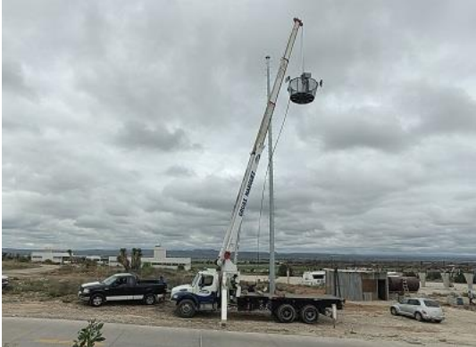
Fotografía 47. Colocación de mástil, Sistema de tres super postes de 20m de altura para alumbrado exterior alimentado por granja solar, noviembre de 2022, Universidad Autónoma de Zacatecas.
