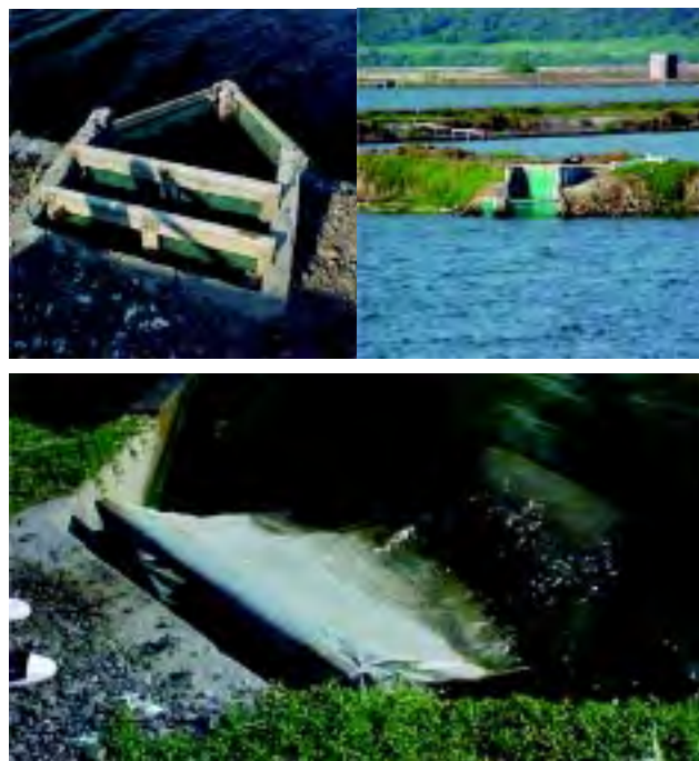
Figura 9 Controlar amigablemente la entrada de organismos silvestres a los estanques mediante la utilización de mallas de diversas medidas en diferentes puntos de flujo de agua, tales como antes de la bomba de agua hacia el reservorio, después de la bomba de agua hacia el reservorio y antes de cada uno de los estanques y al entrar al estanque.
