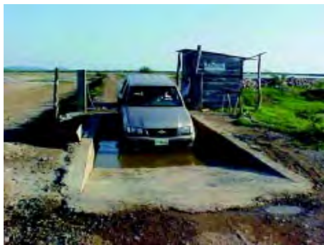
Figura 4 A la entrada de la granja se debe de construir un vado sanitario en el que se coloque solución desinfectante a base de yodo a una concentración de 30 ppm. La solución debe cambiarse frecuentemente. También a la entrada se deben de colocar letreros alusivos a la no entrada de personas autorizadas.
