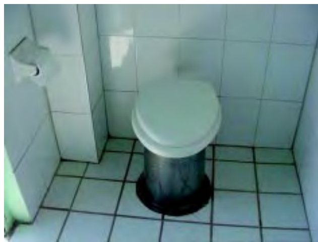
Figura 2 Las letrinas deben estar construidas con materiales fáciles de limpiar como los que se observan.
