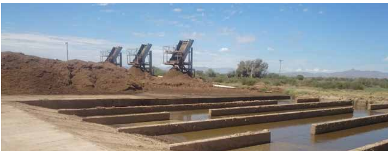
Fig. 51 Fosa de sedimentación
