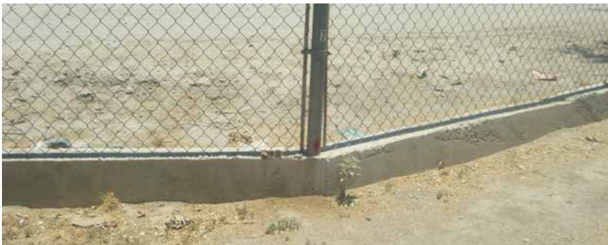
Fig. 56 Barda en buen estado
