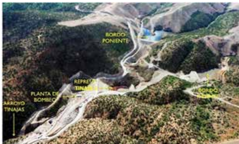
Figura 2. Ubicación de las zonas de trabajo de la Mina Buenavista del Cobre, destaca el sistema de presas Tinajas, en donde ocurrió el derrame de solución acidulada de sulfato de cobre. Fuente: Medina-Rangel, 2019.
