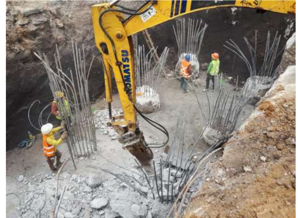
PILAS DE CIMENTACIÓN
