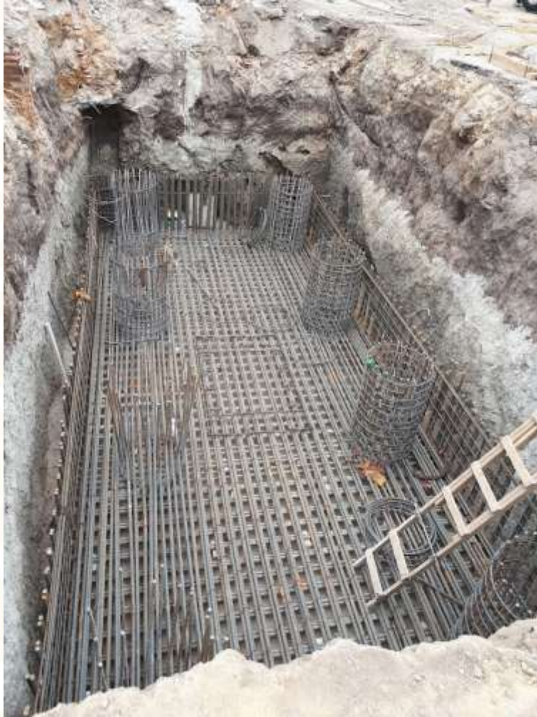
LOSA DE CIMENTACIÓN
