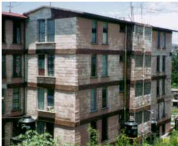
Muros de mampostería con refuerzo interior
