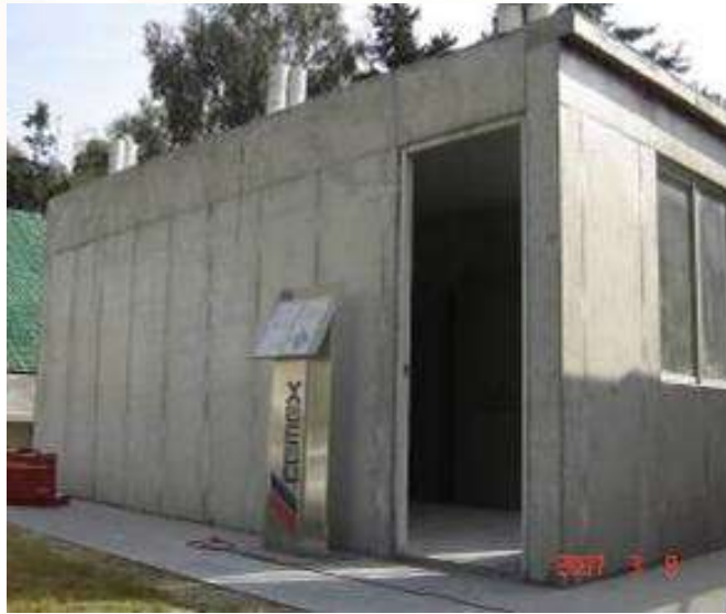
Muros de concreto
