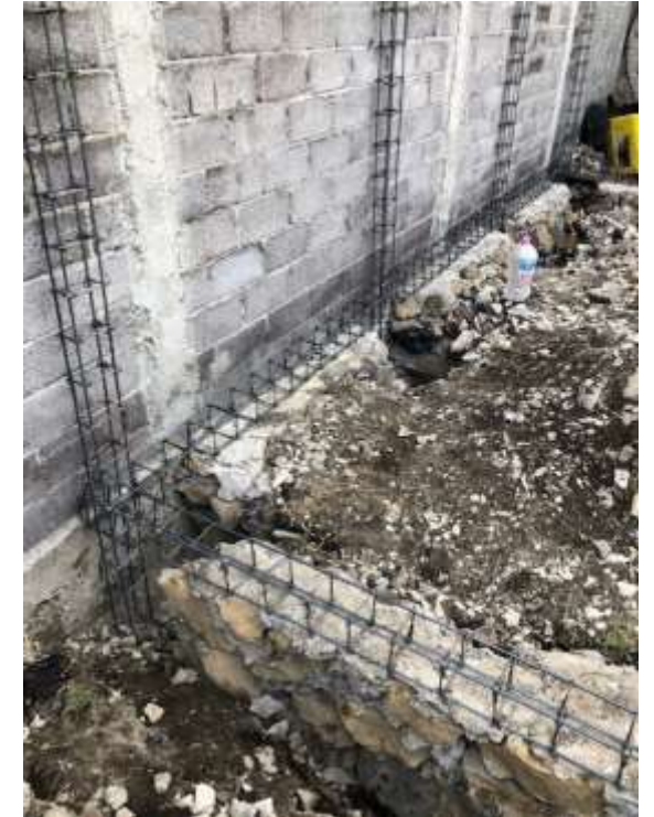
CIMIENTO DE PIEDRA
