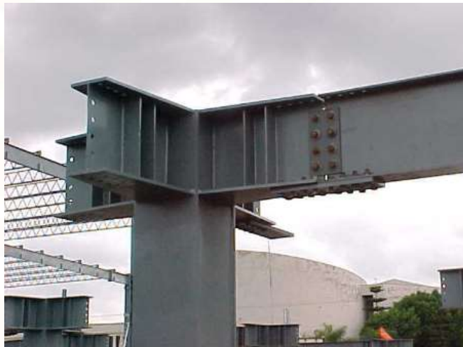
Estructura de acero
