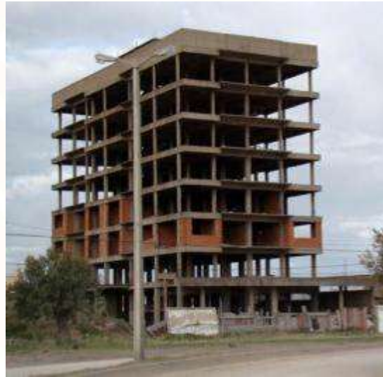
Marcos de concreto
