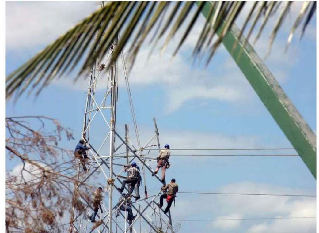
Un grupo de electricistas trabaja en una torre de electricidad en la ciudad de Cancún. JANET SCHWARTZ (TRIBUNE NEWS SERVICE VIA GETTY IMAGES)
