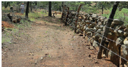
Figura 34. Instalación de un cerco paralelo al cerco existente de un colindante.
