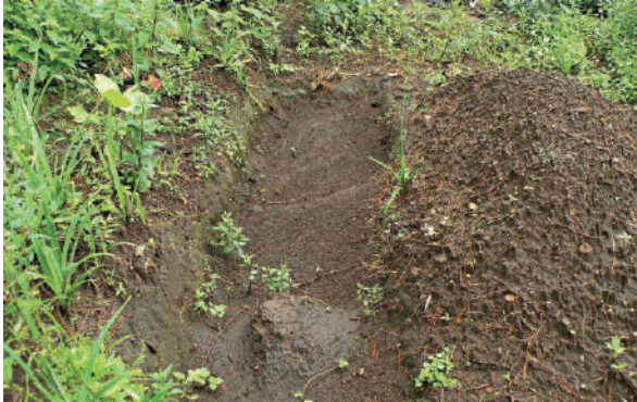
Figura 92. Obra de conservación de suelo en ladera que requiere mantenimiento.
