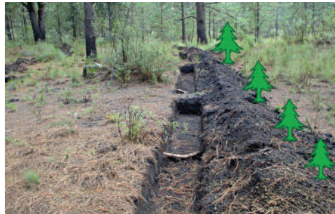
Figura 19. Posición de la planta en obras de zanja bordo.
