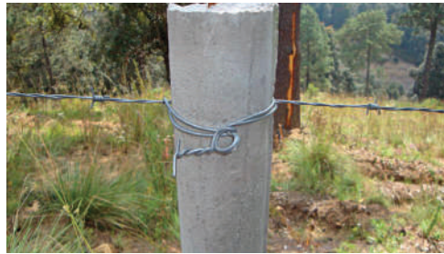
Figura 31. Ejemplo de la correcta fijación del alambre de púas al poste
