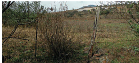
Figura 33. Ejemplo de un cerco deteriorado que debe reemplazarse totalmente.
