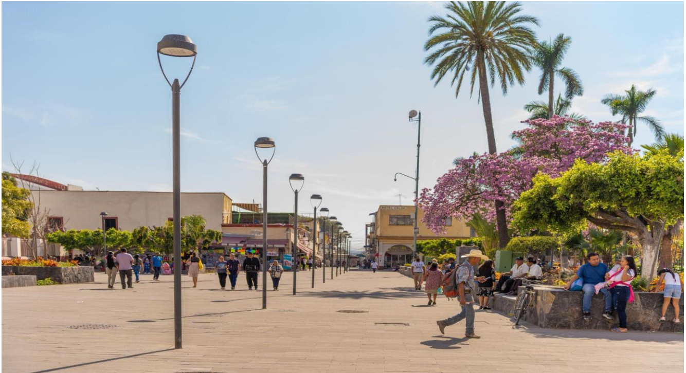
MORELOS. Renovación del Centro Histórico de Cuautla
