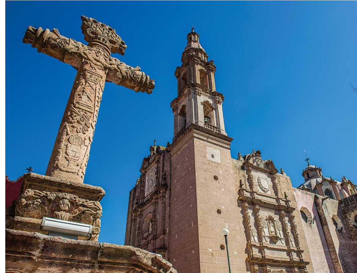
Parroquia de San Mateo Apóstol, Municipal de Huichapan, Hidalgo.
