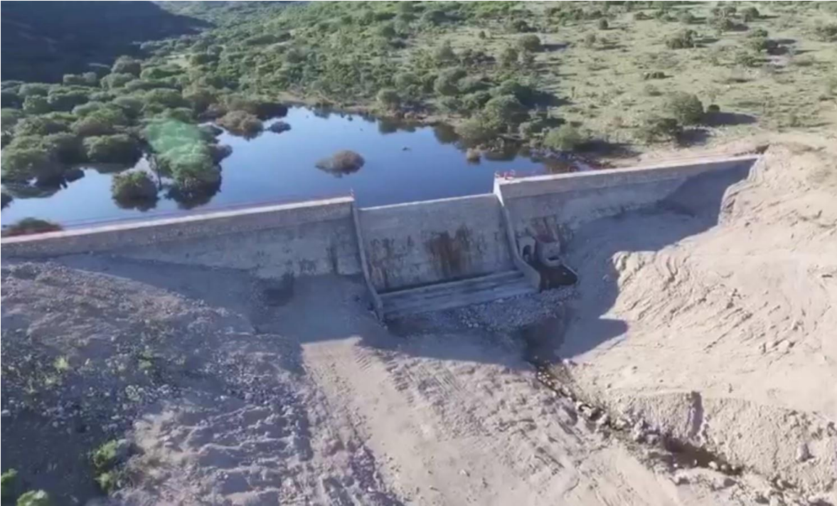
Foto 3. Presa de mampostería que tiene como objetivo un uso eficiente e intensivo del agua al combinarlo con obras de innovación tecnológica.
