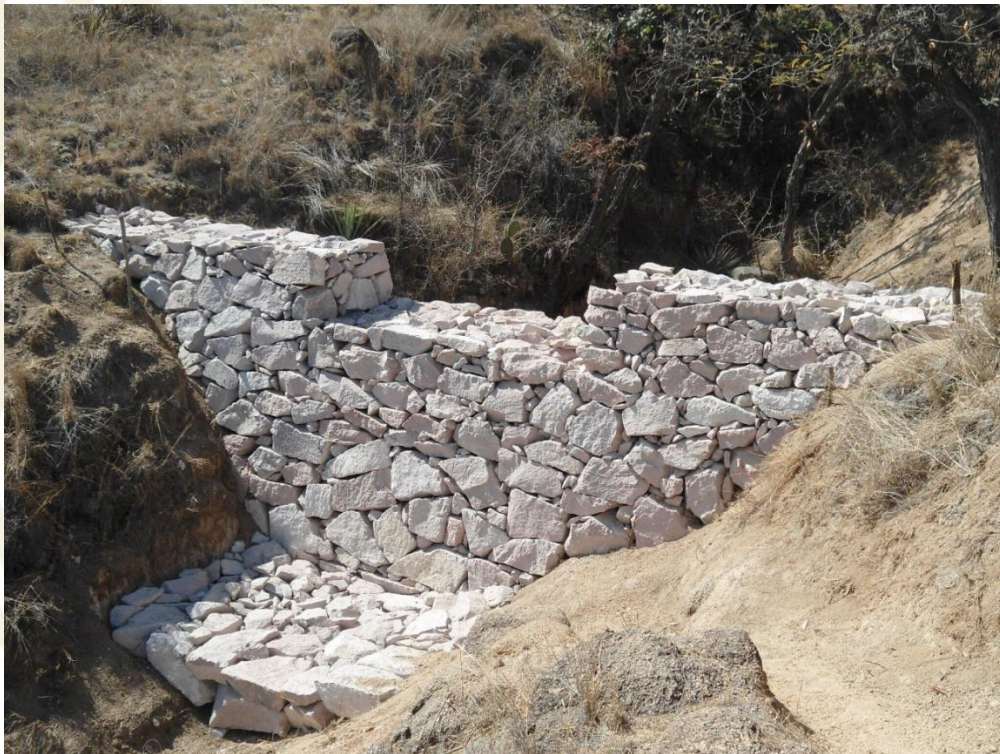
Foto 10. Presa de piedra acomodada para el control de cárcavas en zonas con erosión hídrica
