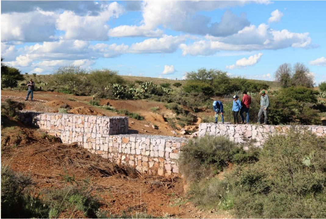
Foto 9. Presa de gaviones para el control de cárcavas, una forma extrema de erosión hídrica.
