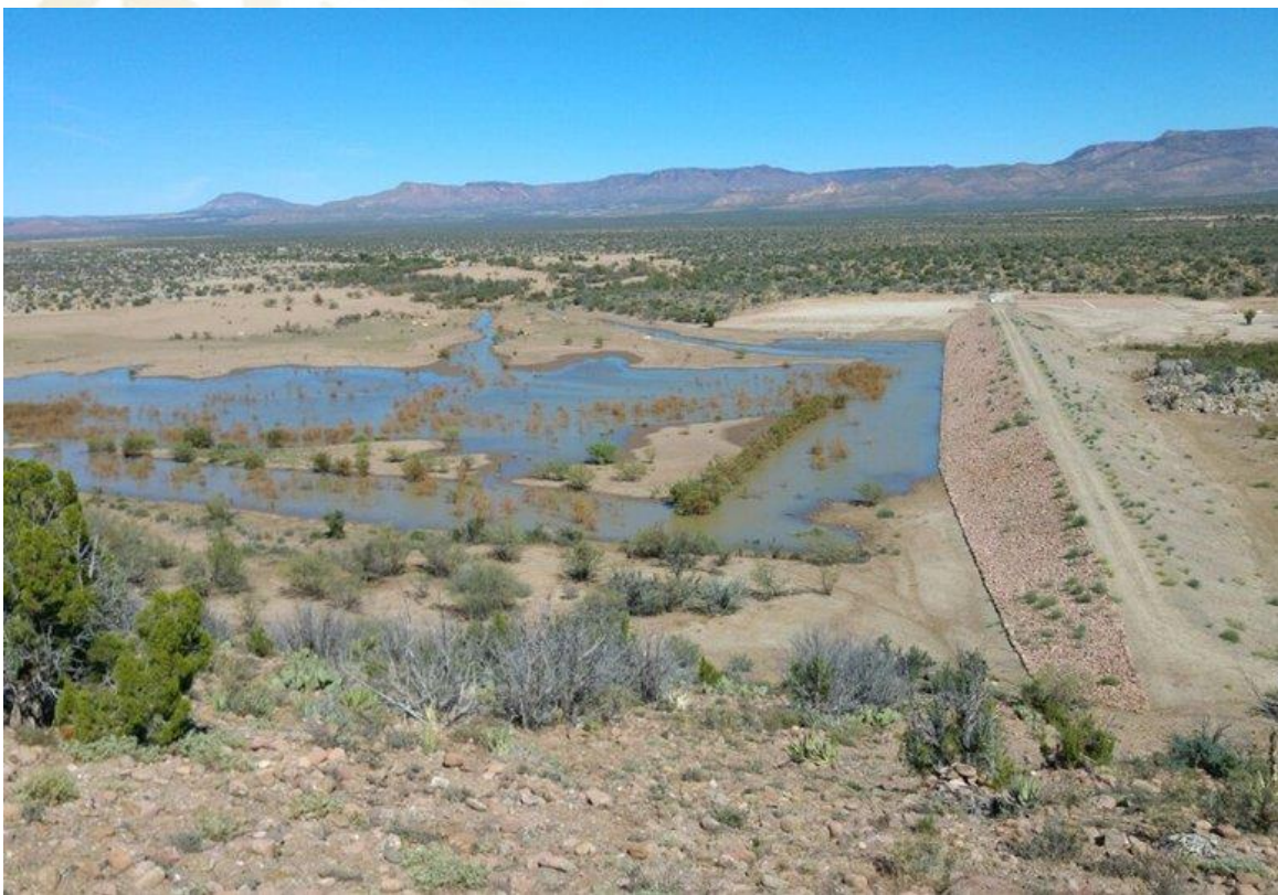
Foto 2. Presa de tierra compactada con fines de complemento a la producción agropecuaria de las zonas áridas y semiáridas de México.
