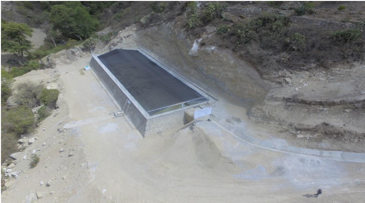
Foto 1. Aljibe, obra hidráulica construida para el suministro de agua con fines domésticos en las zonas áridas y semiáridas de México
