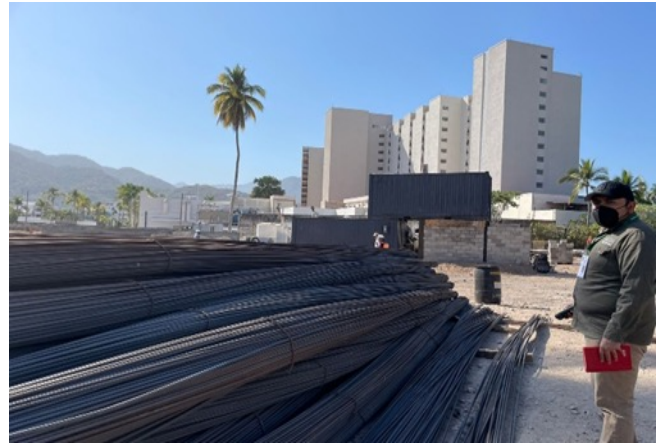
Inspección a Desarrollo Inmobiliario Hotel Now Vallarta, Jalisco
