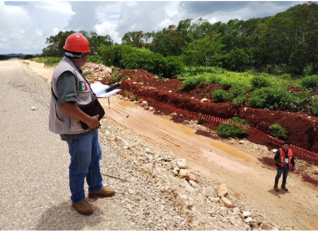
Visita de inspección al Tramo Tres Calkiní-Izamal" del proyecto Tren Maya, Dzitbalché, Campeche
