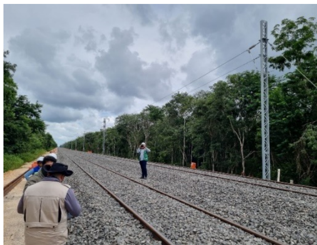
Inspección Tren Maya, Yucatán y Quintana Roo
