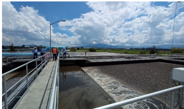
Descargas de aguas residuales.
