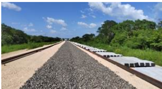
Tendido de material pétreo en tramo 3 en el municipio de Calkiní, Campeche
