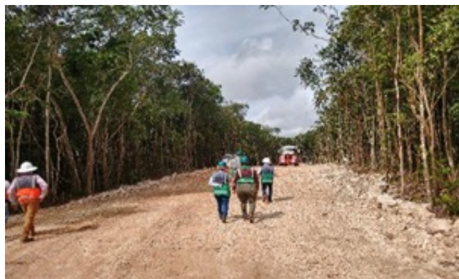
Derecho de vía del Tramo 4, municipio de Benito Juárez, Quintana Roo
