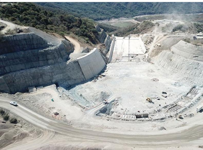
“ Este proyecto consiste en la construcción de una presa de almacenamiento en base a enrocamiento con cara de concreto, y tiene como objetivos fundamentales alimentar a una hidroeléctrica, también, alimenta directamente a una zona de riego de 24 mil 250 hectáreas; nos permite el control de avenidas ”
