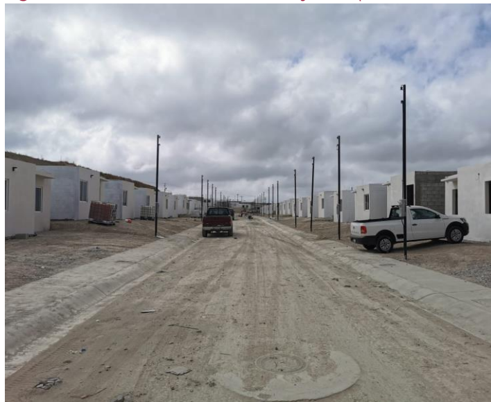
Figura 13. Avance de viviendas en Tijuana (Vista Horizonte)
