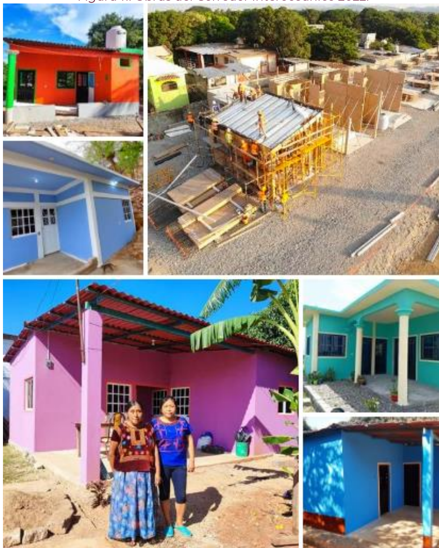
Figura 11. Obras del Corredor Interoceánico 2022.
