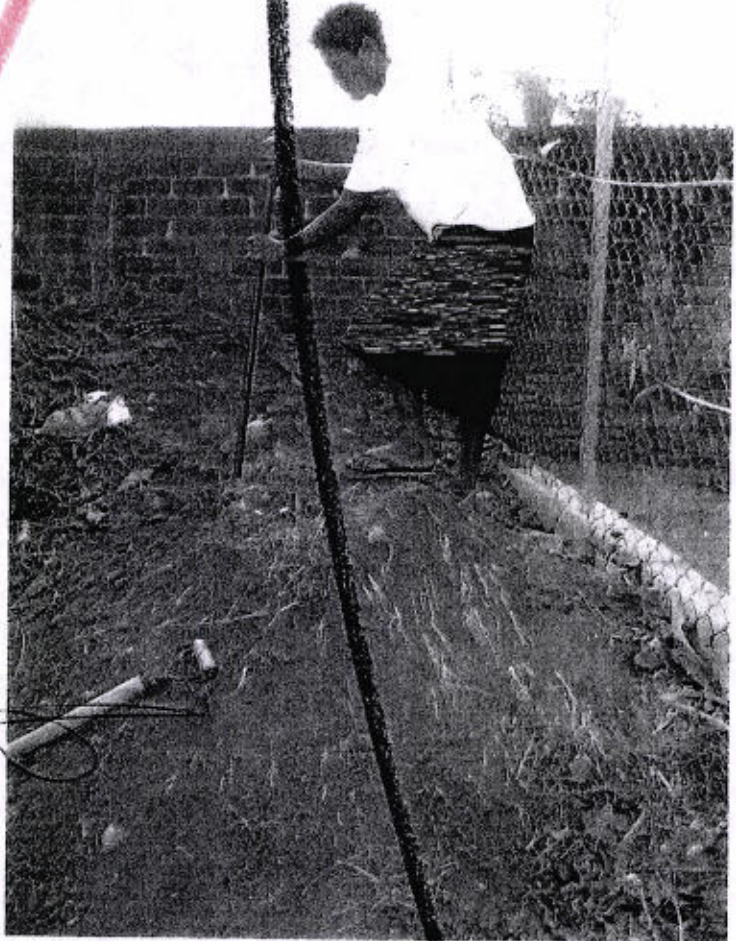
13. FOTOGRAFÍA DEL INICIO DE LA EXCAVACIÓN POR PARTE DE LOS OBREROS, VISTA DE PONIENTE A ORIENTE.
