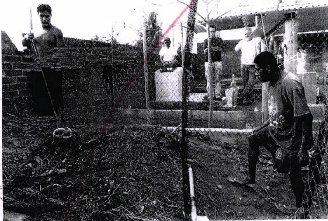
14. FOTOGRAFÍA DEL INICIO DE LA EXCAVACIÓN POR PARTE DE LOS OBREROS, VISTA DE NORTE A SUR.
