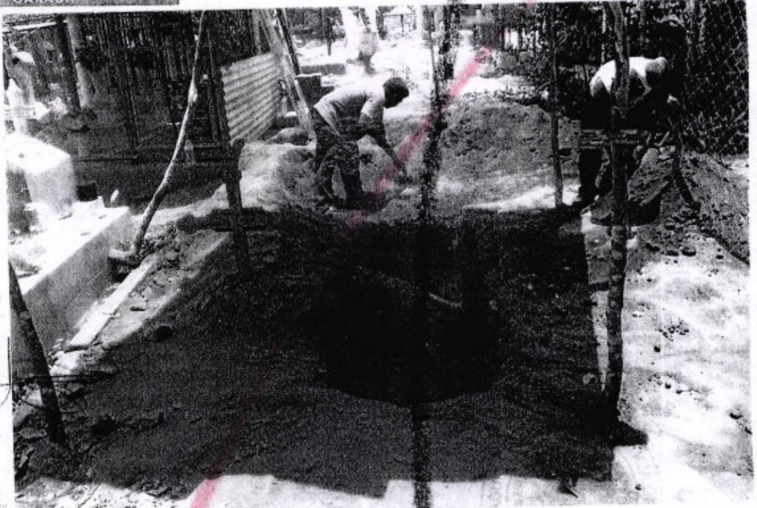
93. FOTOGRAFÍA DEL PROCEDIMIENTO DE COLOCACIÓN DE TIERRA SOBRE LA ZONA DE FOSA CAVADA DENOMINADA ÁREA 2.
