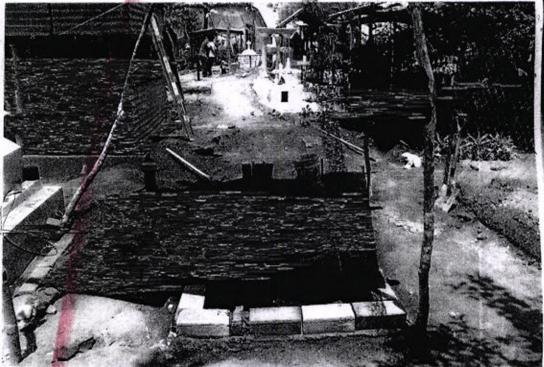
96. FOTOGRAFIA DEL AVANCE DE LA CONSTRUCCION DE LA LAPIDA POR LO OBREROS.
