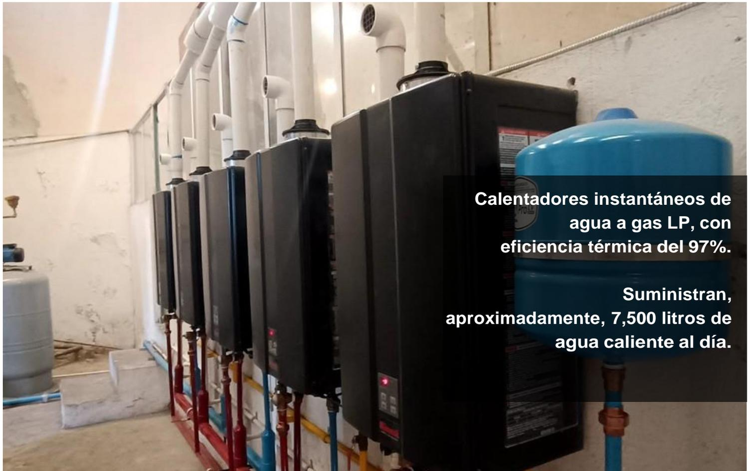
**Calentadores instantáneos de agua a gas LP, con eficiencia térmica del 97%.**
