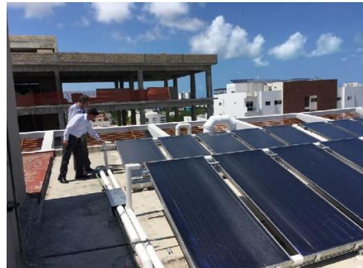
**Fotografía 08.** Arreglo de las tuberías de agua caliente del proyecto, Calor Solar en el Sector Servicios en Cancún, Q.R., mayo de 2018. CONUEE.
