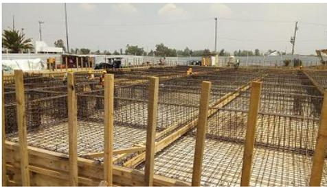
**Fotografía 32.** Cimentación para elementos estructurales, Bordo oriente, Etapa IV, diciembre de 2020. Proyecto Valorización de fracción orgánica de residuos sólidos urbanos (FORSU) mediante carbonización hidrotermal. UNAM.
