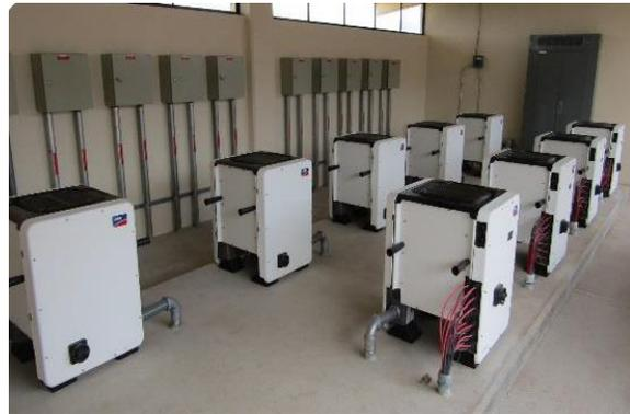
**Fotografía 21.** Inversores y tablero i-line, junio de 2019, Huajuapán de León, Oax. Proyecto Jardín Solar fotovoltaico de 0.48 MW en la U.T.M.
