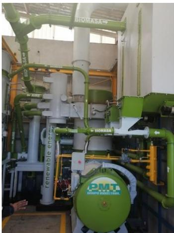
**Fotografía 22.** Sistema para destrucción térmica de residuos sólidos como combustible, junio de 2020. Proyecto Mecanismo de Fondo revolvente para el Financiamiento.
