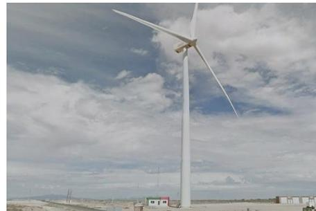
**Fotografía 16.** Aerogenerador de 2.0 MW, capacidad nominal de 9,533 MWh/año, Puerto Peñasco, Son., mayo 2017, proyecto Energía Sonora PPE, S.C.
