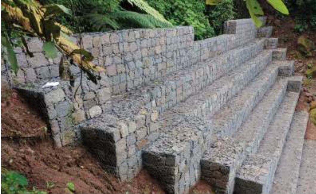
Imagen 66. Presa de gaviones para retención de suelo.
