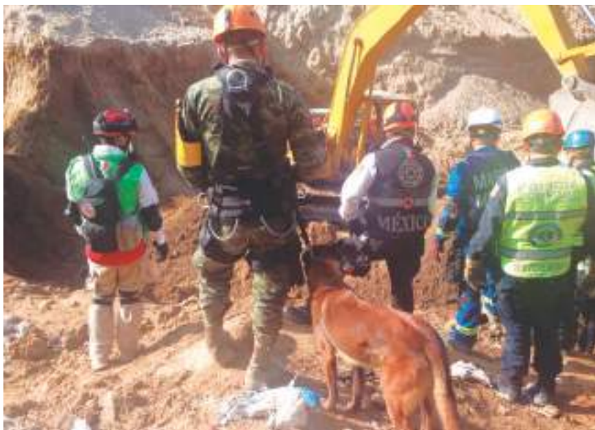
Los equipos de México y Guatemala trabajando mano a mano en el rescate de cuerpos en la zona de desastre de Cambray II, Guatemala, 4 de octubre de 2015.
