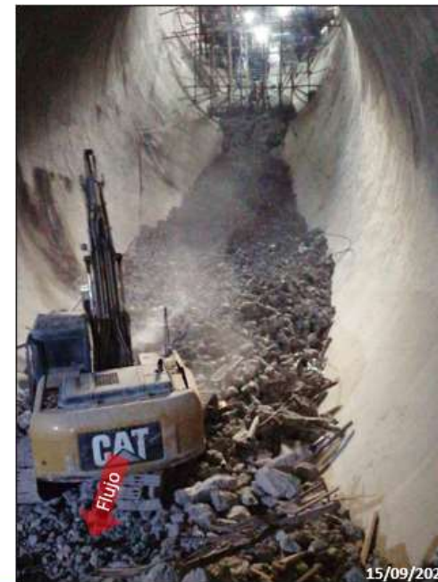
Limpieza de rezaga producto de demolición en el Aireador 1
