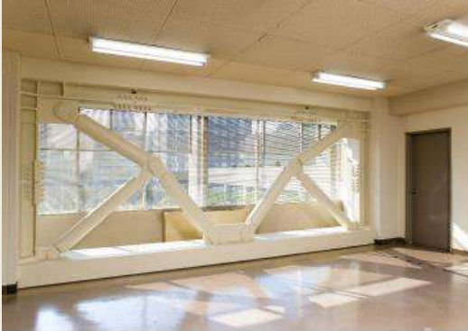
Instalación de los arriostres con amortiguador de masa sintonizado
