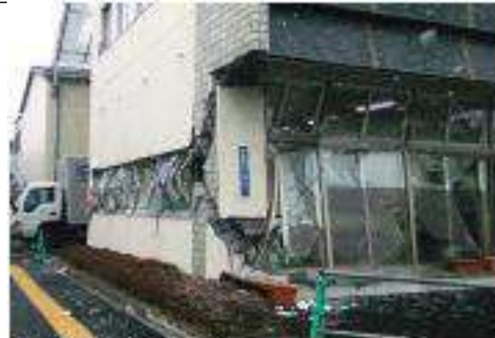
地震により壊壊したビル (震後4時間)
