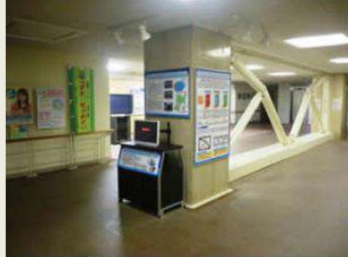
Además de arriostramiento, se instaló el sismógrafo en la planta baja.
