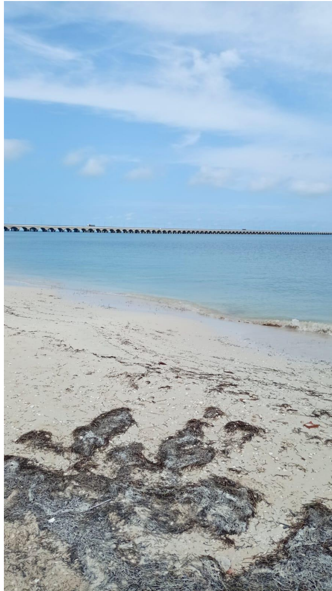
Fotografía de Progreso Puerto del 09 de septiembre de 2022
