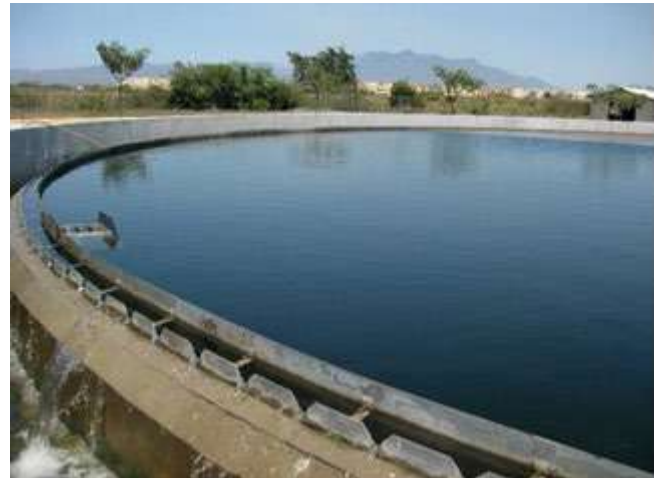
Sedimentador secundario
