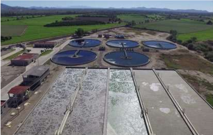
Vista aérea del sistema de lodos activados
