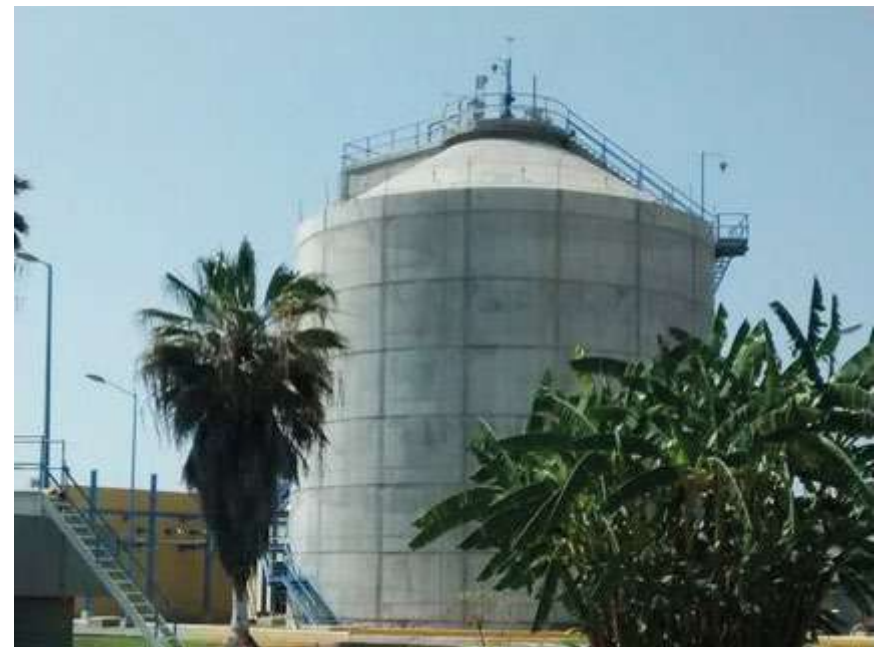
Digestor anaerobio de lodos
