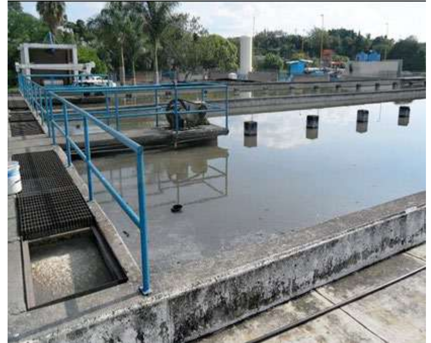
Sedimentador secundario
