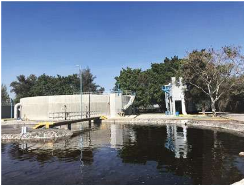
Sedimentador secundario
