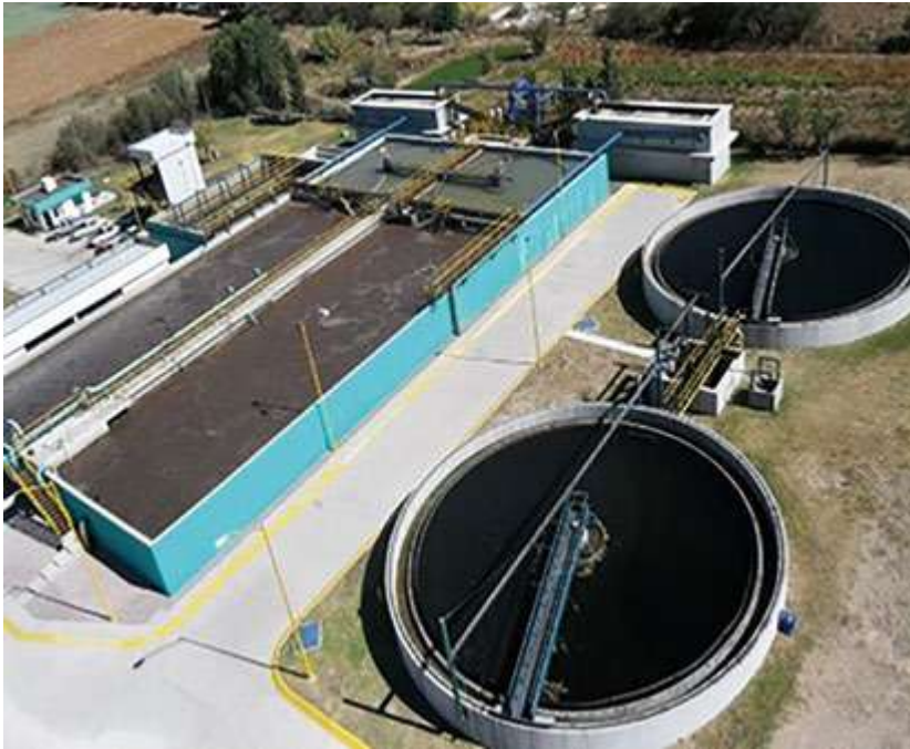
Reactores aerobios y sedimentadores secundarios
