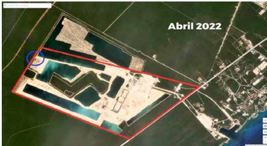
Figura 72. Área impactada en abril de 2022.
