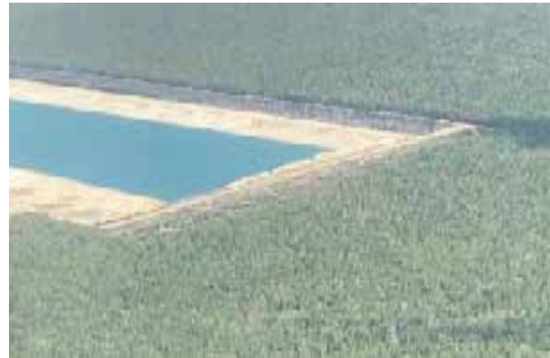
Figura 55. Fotografía aérea que muestra el desmonte, despalme y exposición de manto freático.
