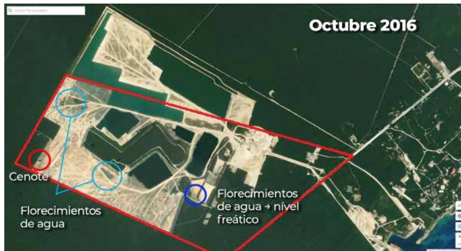
Figura 69. Área impactada en octubre de 2016.
