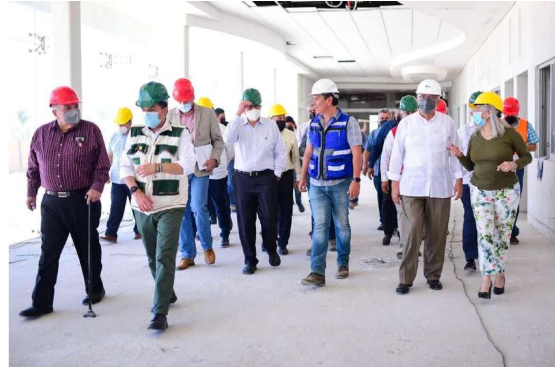
Recorrido de supervisión de obra el 17 de marzo
