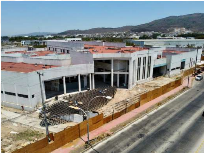
Construcción del Hospital de la Mujer
