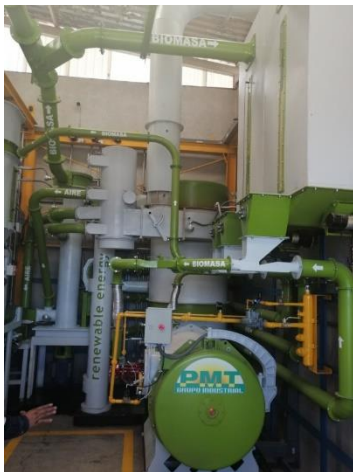
Fotografía 22. Sistema para destrucción térmica aprovechable de residuos sólidos como combustible, junio de 2020. Proyecto Mecanismo de Fondo revolvente para el Financiamiento.
