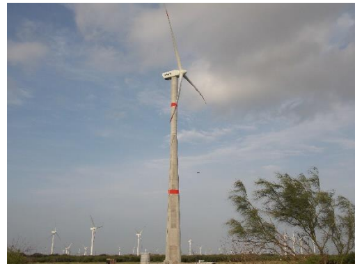
Fotografía 14. Aerogenerador de 2 MW clase 1, instalaciones del Centro Regional de Tecnología Eólica en Juchitán, Oax., marzo 2018, Proyecto Juchitán Sustentable. INEEL.
