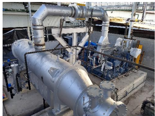
Fotografía 18. Turbina de VSC multietapa de 1000 kW junio de 2019, Santiago Papasquiari, Dgo. Proyecto Cogeneración para abastecimiento. SEZARIC.
