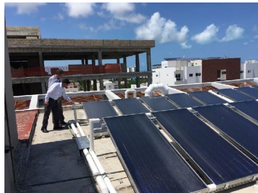
Fotografía 08. Arreglo de la tuberías de agua caliente del proyecto, Calor Solar en el Sector Servicios en Cancún, Q.R., mayo de 2018. CONUEE.
