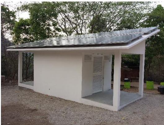
Fotografía 34. Arreglos fotovoltaicos para el sistema de electrificación de El Madresal, Chis., febrero 2017, proyecto Centros Ecoturísticos a través de Energías Renovables. Instituto de Energías Renovables del Estado de Chiapas.
