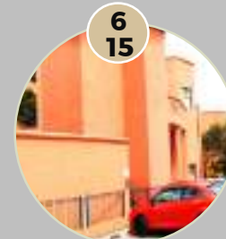
RFI: 11-6848-0 y 11- 11336-1 EDIFICIO PRINCIPAL DEL CIMAT AC
