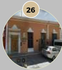
RFI: 4-327-0 BODEGA (EXGUARDERÍA ORDINARIA 001)
