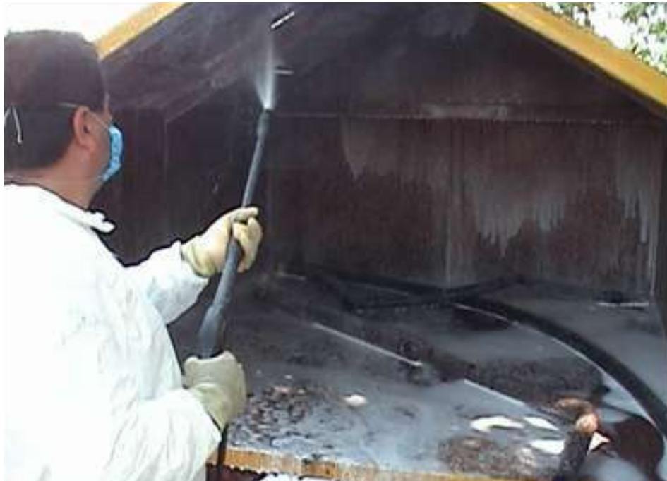
Imagen 55.- Lavado y desinfección de un contenedor utilizado como cámara de CO 2 .
