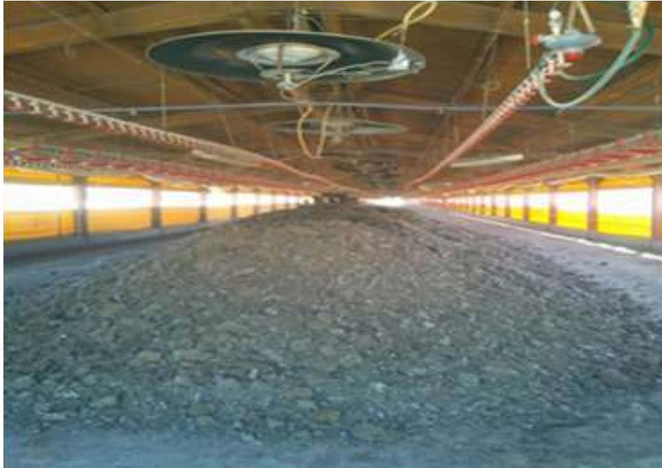
Imagen 65.- Amontonamiento de las excretas al centro de la caseta.
