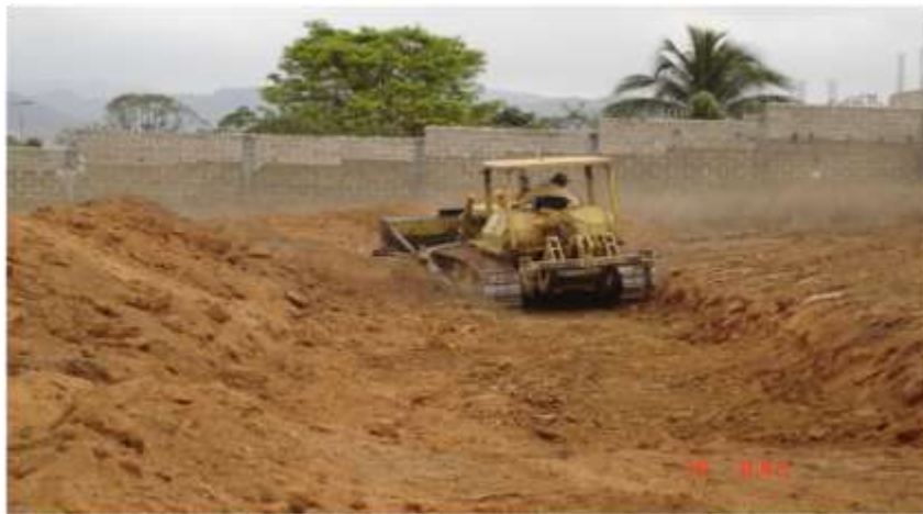
Imagen 40.- Inicio de construcción de una fosa.
