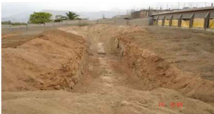
Imagen 41.- Fosa terminada dentro de una unidad de producción avícola.
