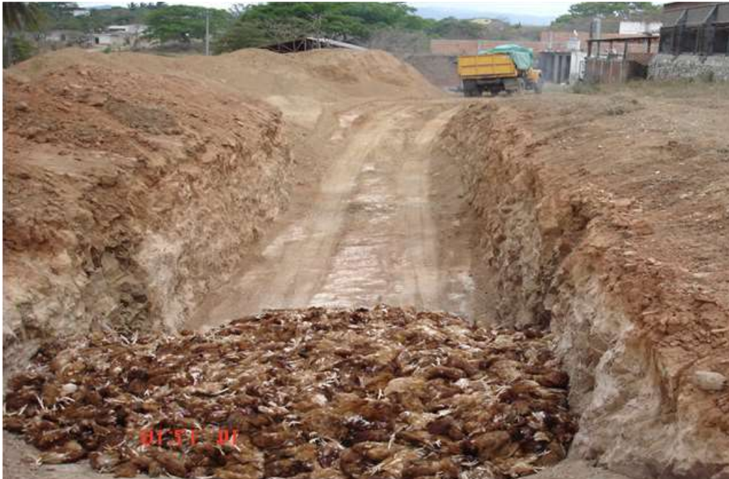
Imagen 42.- Fosa con terraplén para facilitar el acceso de los vehículos.
