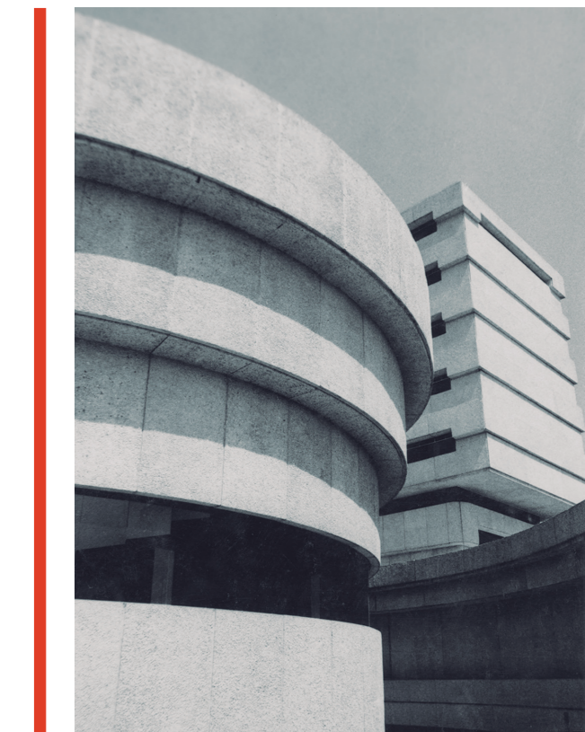
UMAE HOSPITAL GENERAL DE OBSTETRICIA N. 4 "LUIS CASTELAZO AYALA", CUERPO CIRCULAR Foto: Archivo de Arquitectos Mexicanos, Facultad de Arquitectura. UNAM. Fondo Agustín Hernández Navarro.
