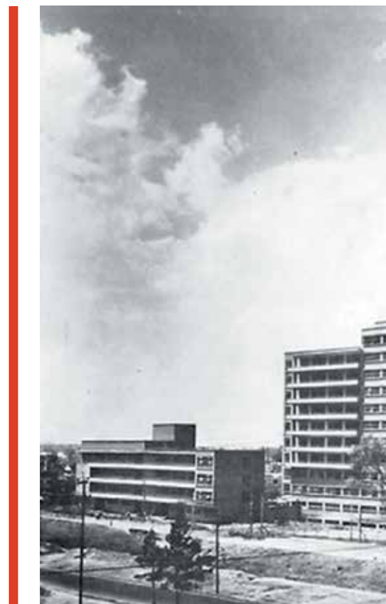
VISTA PANORÁMICA DEL HOSPITAL "LA RAZA" DESDE AVENIDA JACARANDAS Foto: Guillermo Zamora. Imagen del Archivo de Arquitectos Mexicanos, Facultad de Arquitectura. UNAM. Fondo Enrique Yáñez de la Fuente.
