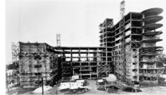
CONSTRUCCIÓN DEL HOSPITAL DE ZONA EN MONTERREY NUEVO LEÓN, HACIA 1951 Foto: Autor desconocido, publicada en 50 Años Cumpliendo IMSS: Una Historia Compartida 1943-1993, México, IMSS, 1993.
