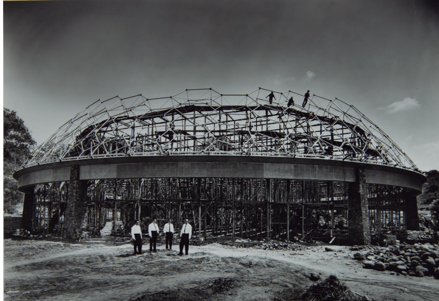
CÚPULA GEODÉSICA EN CONSTRUCCIÓN Foto: Guillermo Zamora, hacia1963. UNAM. Archivo de Arquitectura Mexicana y Cultura Visual del siglo XX. Fondo Alejandro Prieto Posada. En proceso de catalogación.
