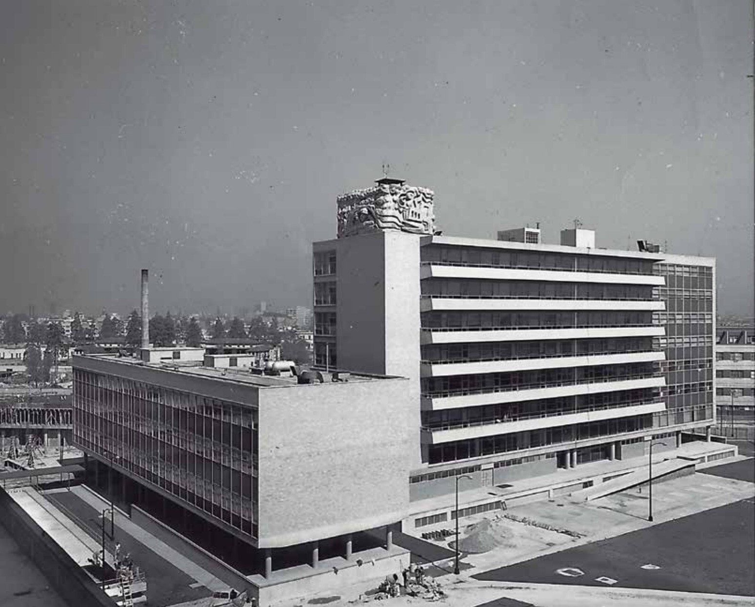
CENTRO MÉDICO NACIONAL. HOSPITAL DE NEUMOLOGÍA. VISTA GENERAL. Foto: Brehme. Imagen del Archivo de Arquitectos Mexicanos, Facultad de Arquitectura. UNAM. Fondo Enrique Yáñez de la Fuente.
