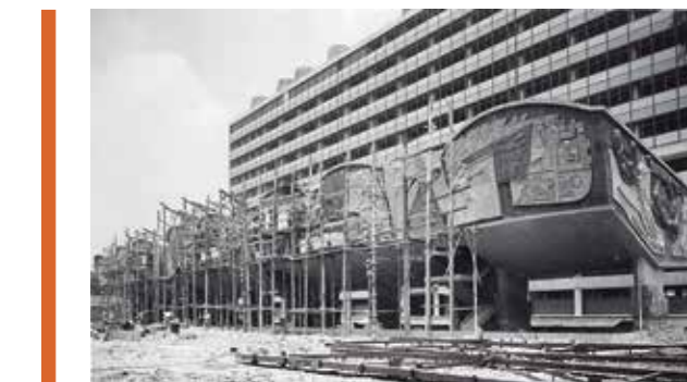
CENTRO MÉDICO NACIONAL. GRUPO DE AULAS. MURALES ESCULTÓRICOS DE JOSÉ CHÁVEZ MORADO, EN PROCESO Foto: Luis Limón Aragón. Imagen del Archivo de Arquitectos Mexicanos, Facultad de Arquitectura. UNAM. Fondo Enrique Yáñez de la Fuente.
