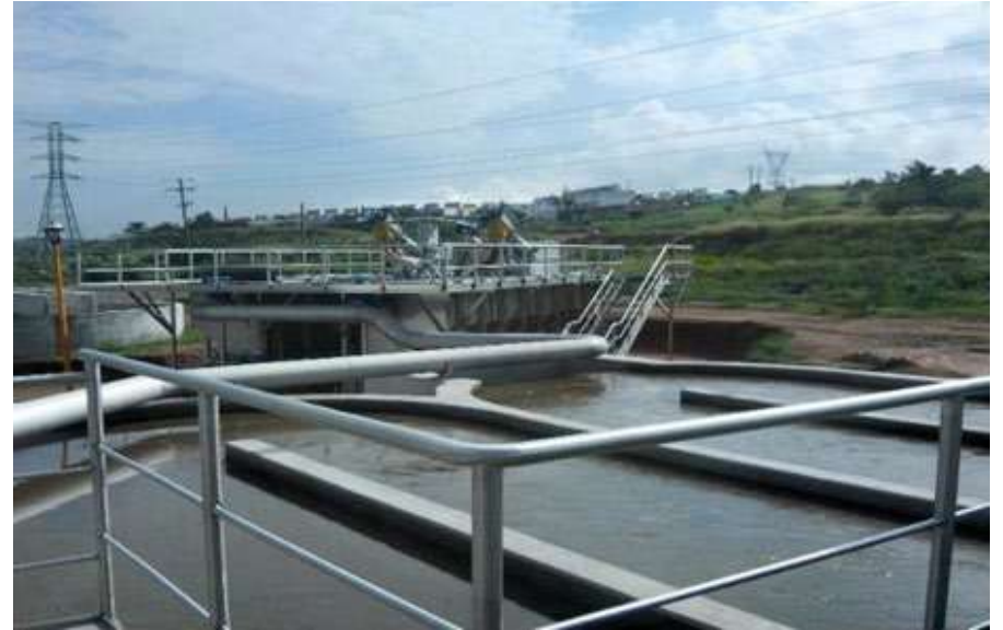
Zanja de oxidación
