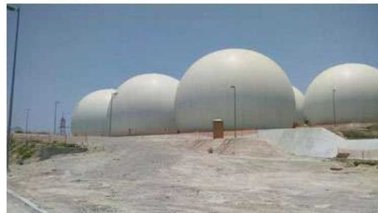
Almacenamiento de biogás
