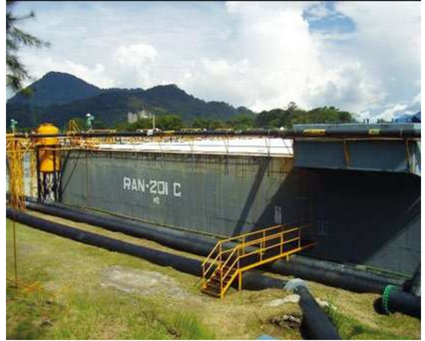
Reactor Anaerobio de Flujo Ascendente
