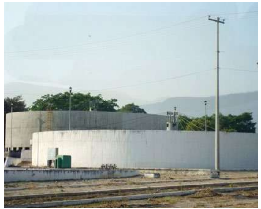
Filtros biológicos (percoladores)
