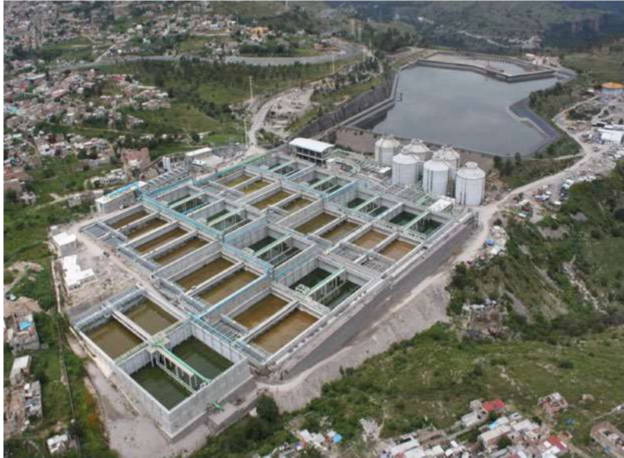
Vista aérea de la planta
