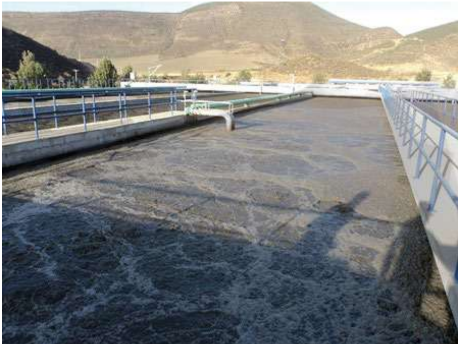
Zanjas de oxidación
