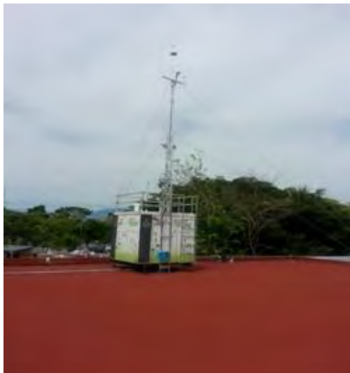
Figura 13. Exterior de la caseta de monitoreo.
