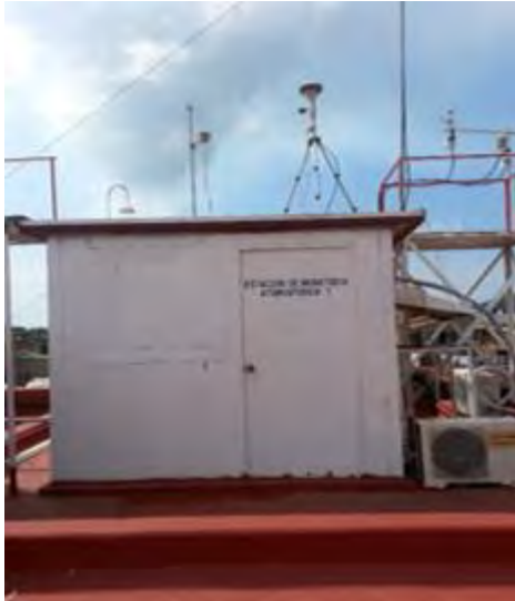
Figura 18. Exterior de la caseta de monitoreo.
