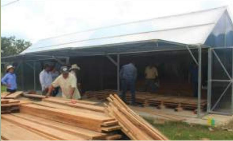
8a. SECADOR SOLAR DE MADERA CON
