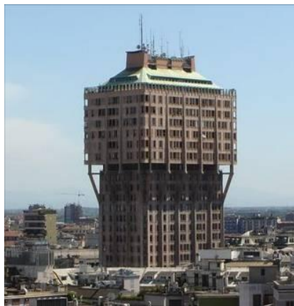
Figura 3.35 Cambio abrupto de la planta en niveles superiores
