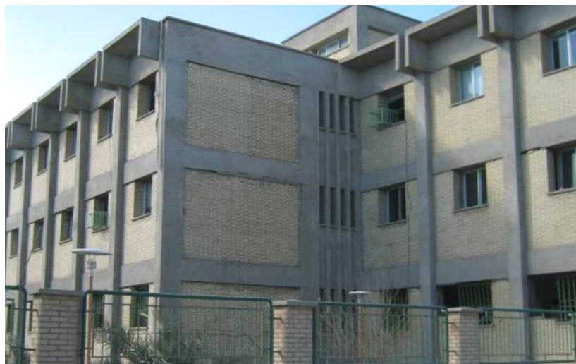
Figura 3.13 Muros diafragma de mampostería
