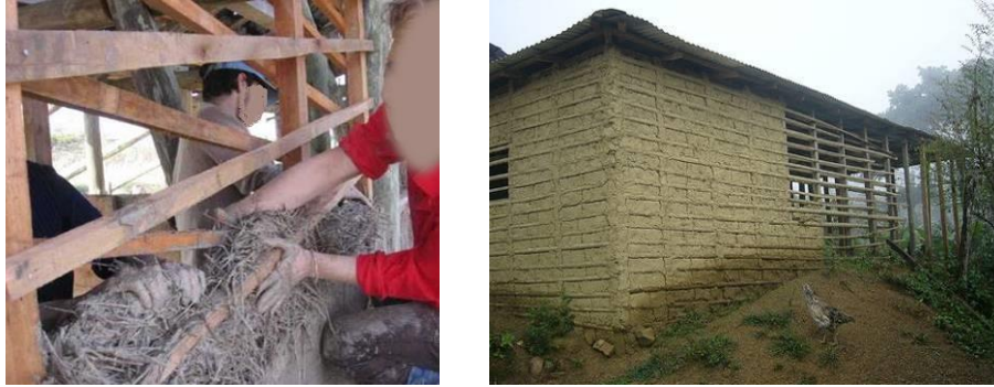
Figura 3.14 Fabricación de bahareque
