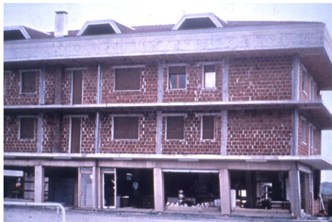
Figura 3.32 Planta baja flexible
