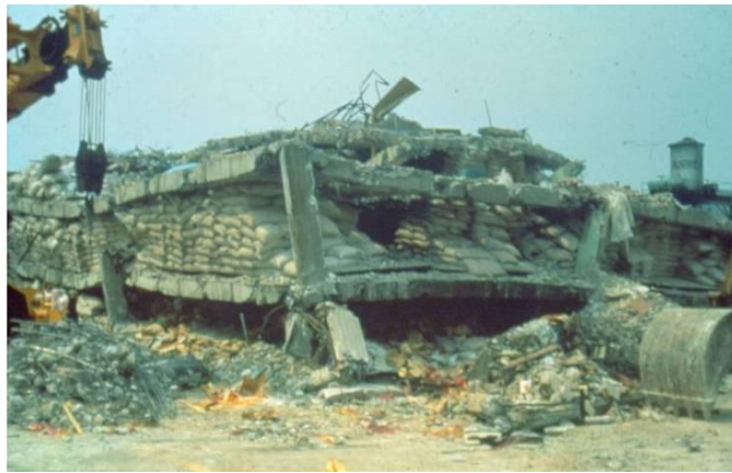
Figura 3.34 Grandes masas en pisos superiores
