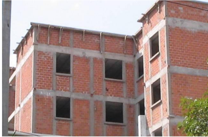
Figura 3.12 Muros de carga de mampostería
