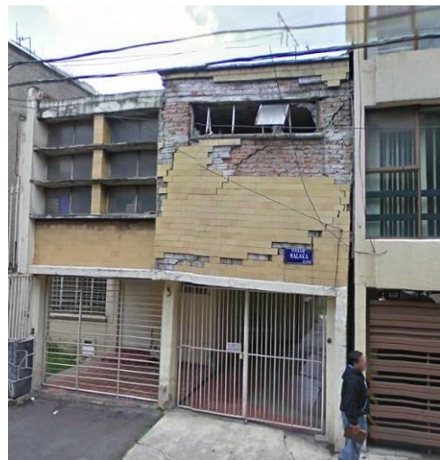
Figura 3.38 Hundimientos diferenciales
